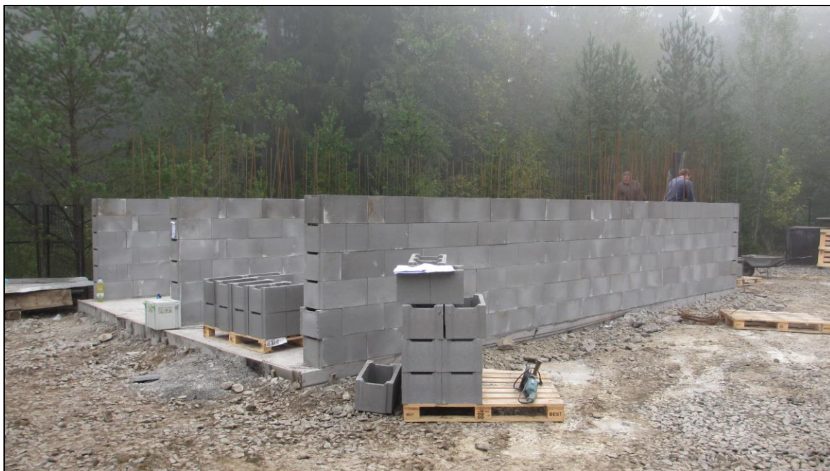
Pohled na objekt
