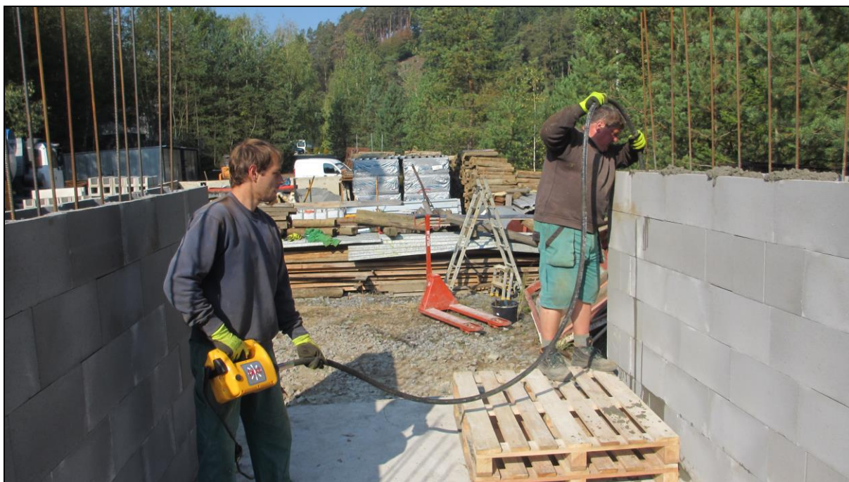
Vibrování výplňového betonu stěn objektu
