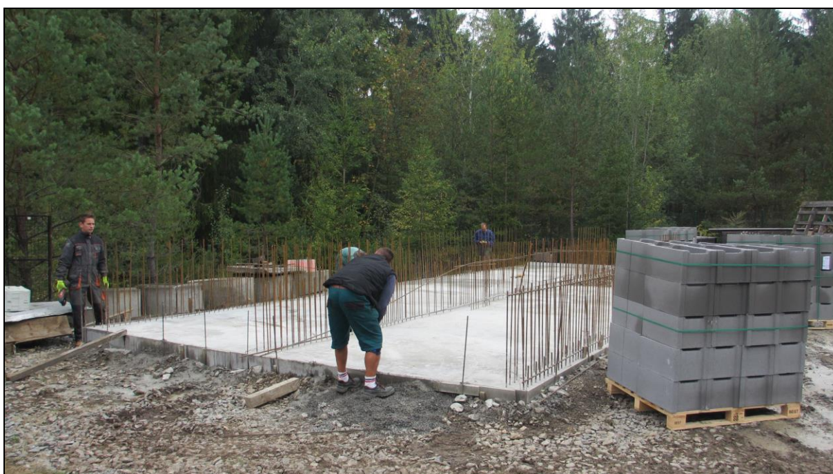
Dokončená betonáž desky dna
