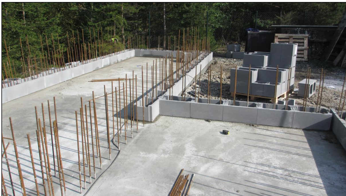
Pohled na objekt (deska dna a základ bočních zdí)
