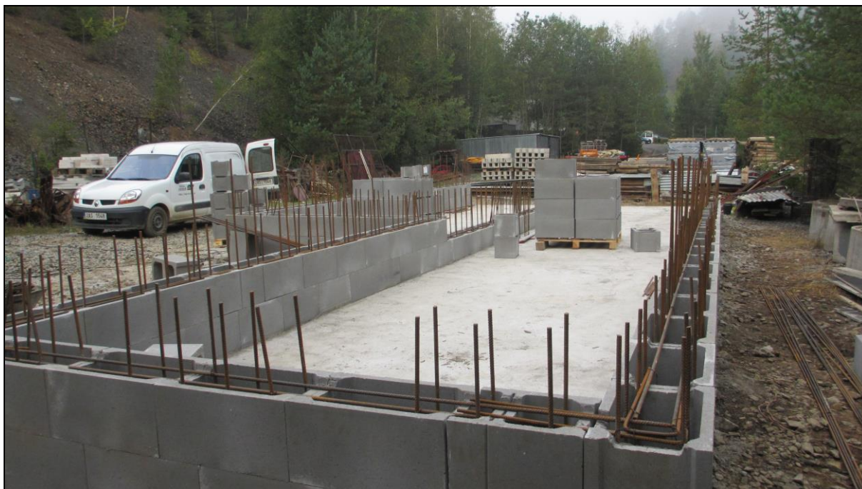
Vyzdívání stěn objektu
