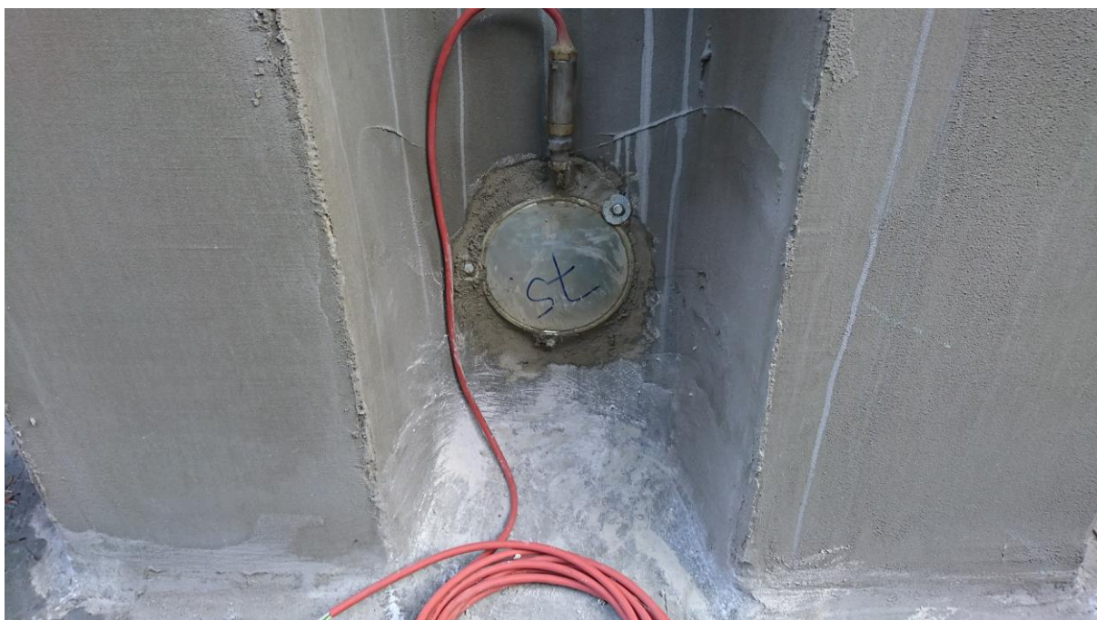
Nainstalované geostatické čidlo
