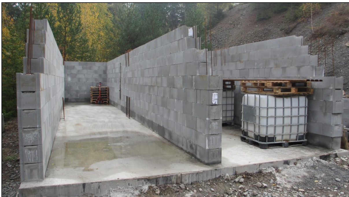
Pohled na objekt
