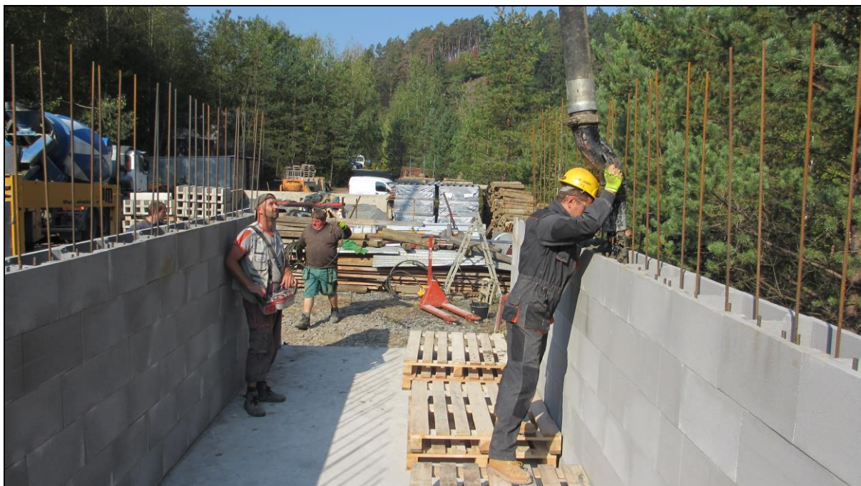
Výplňový beton stěn objektu
