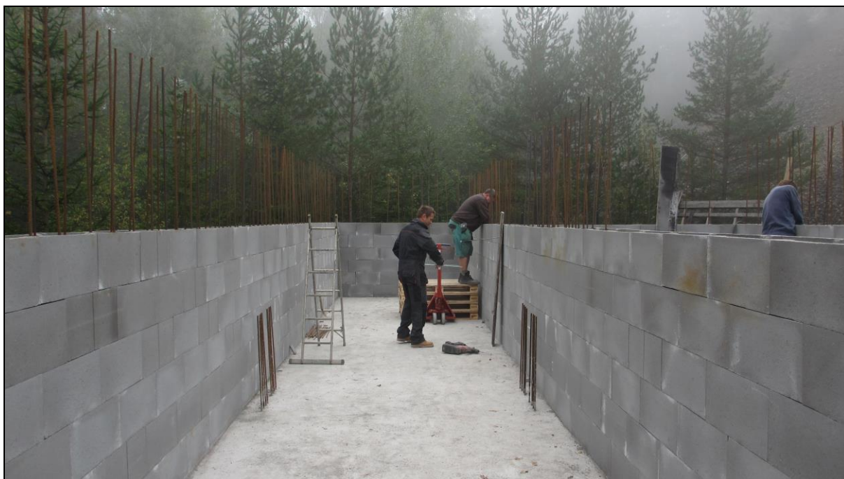
Vyzdívání stěn objektu
