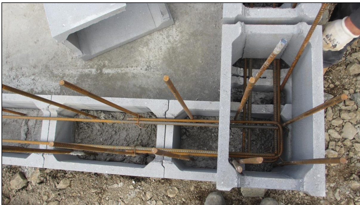
Bednicí tvárnice a armatura stěn
