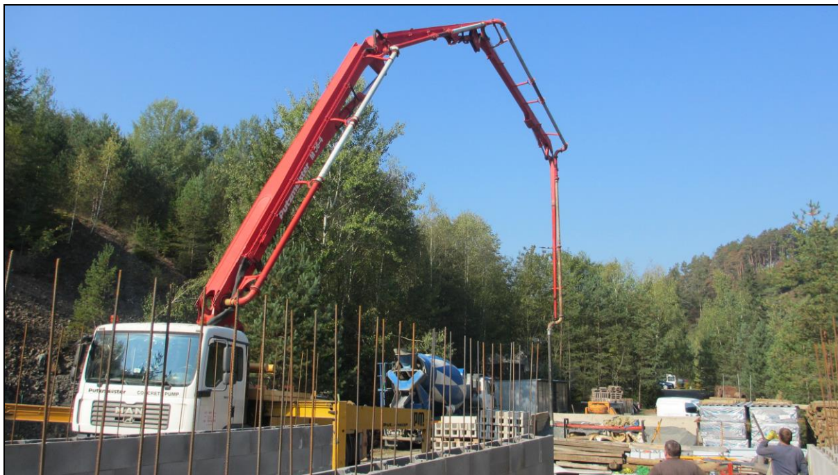
Betonáž stěn objektu
