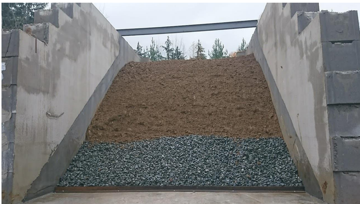
Dokončená hráz s patním drénem
