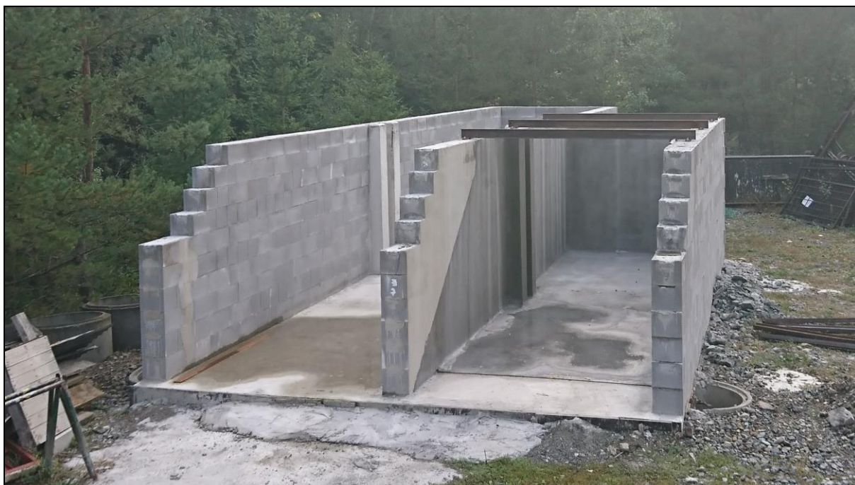
Celkový pohled na objekt (pravá sekce opatřena hydroizolací a rozpěrami zdí)
