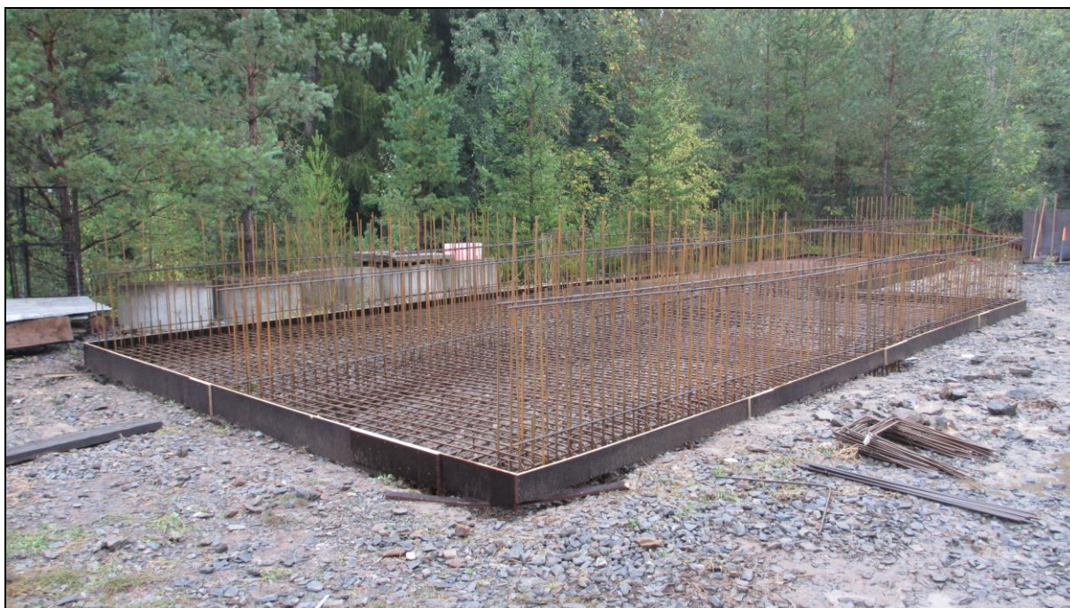
Bednění a armatura desky dna
