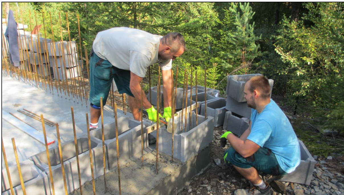
Vyzdívání stěn (tvárnice ztraceného bednění)
