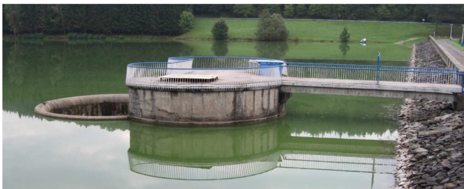
Obr. 8: Pohled na přeliv a hráz VD Ludkovice
