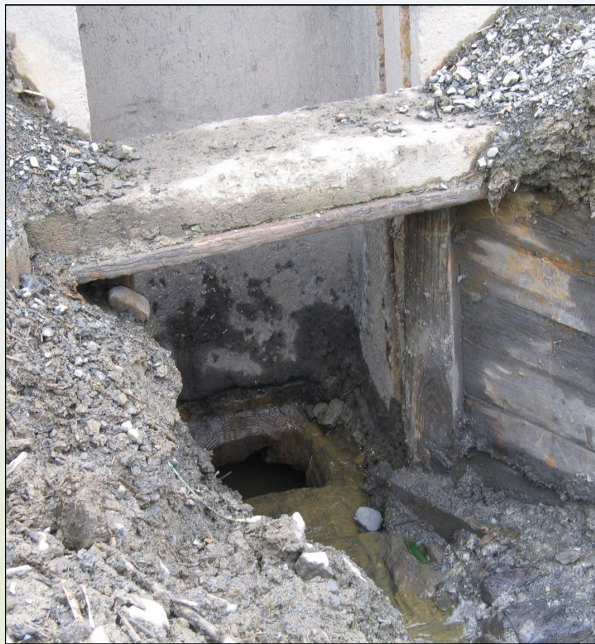
Otvor pro osazení čepu na původním dřevěném potrubí – Libešický r.
