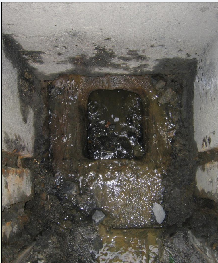
Otvor pro osazení čepu na původním dřevěném potrubí – Libešický r.
