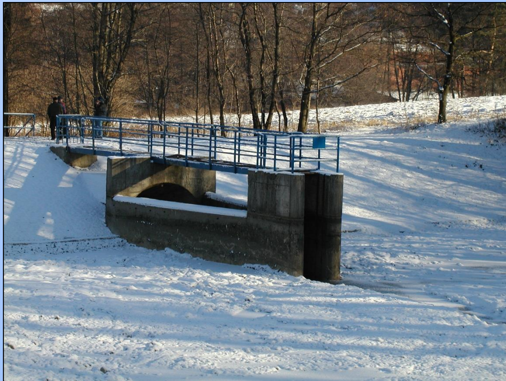
šoupátkový uzávěr na výpusti MVN v Petrovicích – Milíčovský potok
