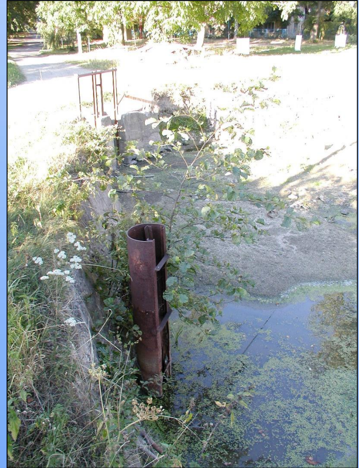
primitivní nefunkční požerák – MVN v Čenětících, Botič
