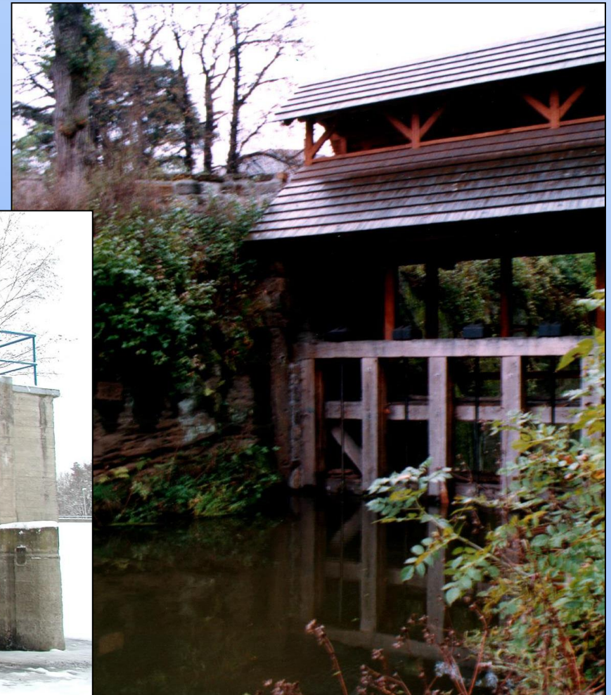
obnovená stavidlová výpust na Novozámeckém rybníce
