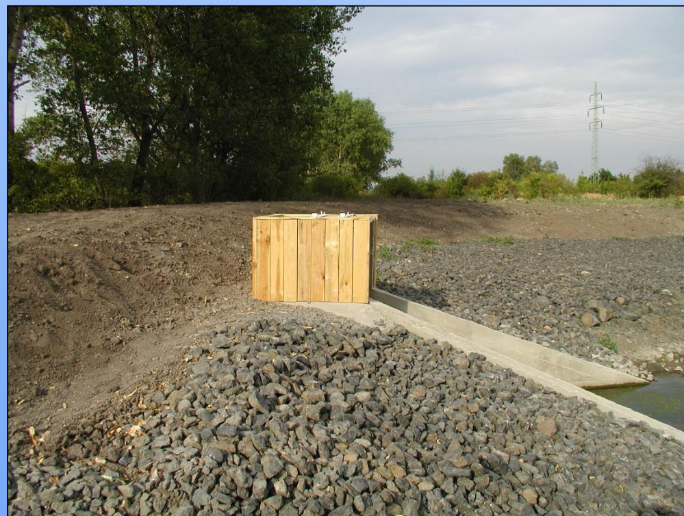
požerák na poldru v Sulejovicích (Modla) – dvojitá dlužová stěna, česle, obklad dřevem
