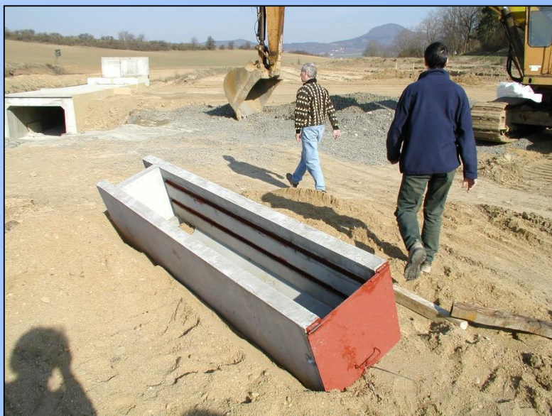
požerák jako součást sdruženého objektu – ve výstavbě – MVN Břehoryje
