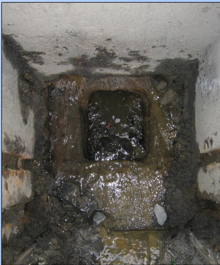
otvor pro osazení čepu na původním dřevěném potrubí – Liběšický rybník
