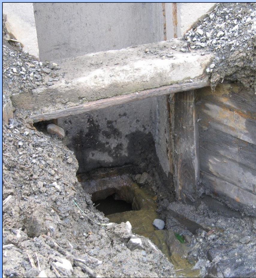
otvor pro osazení čepu na původním dřevěném potrubí – Liběšický rybník
