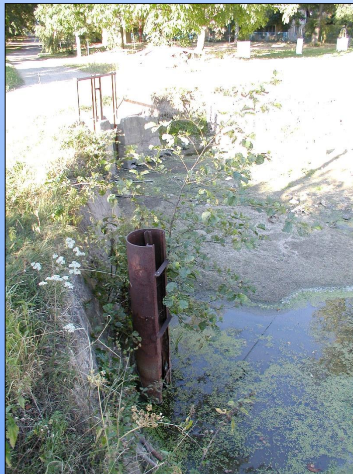
primitivní nefunkční požerák – MVN v Čeněticích, Botič
