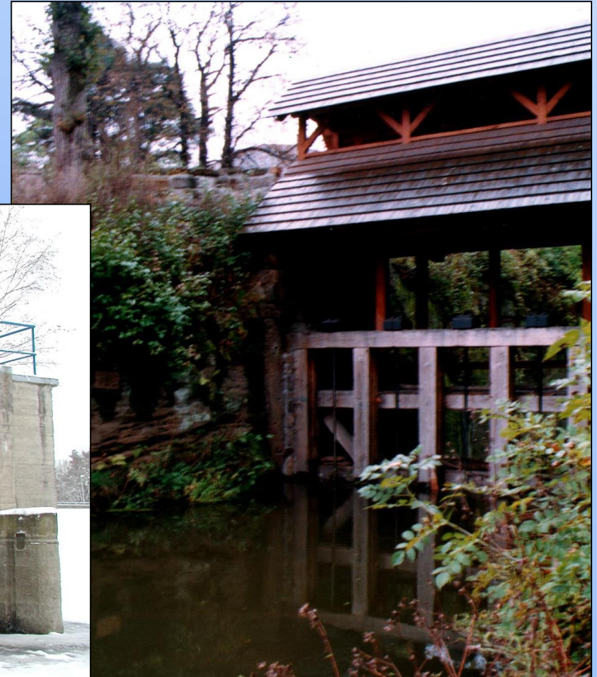
obnovená stavidlová výpust na Novozámeckém rybníce
