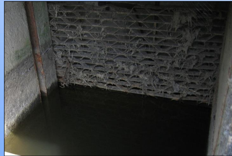
nevhodné „česle“ – MVN na toku Olešné u obce Olešná na Pelhřimovsku
