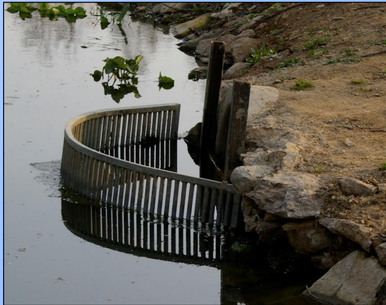
MVN v obci Staré Bříště (okr. Pelhřimov)
