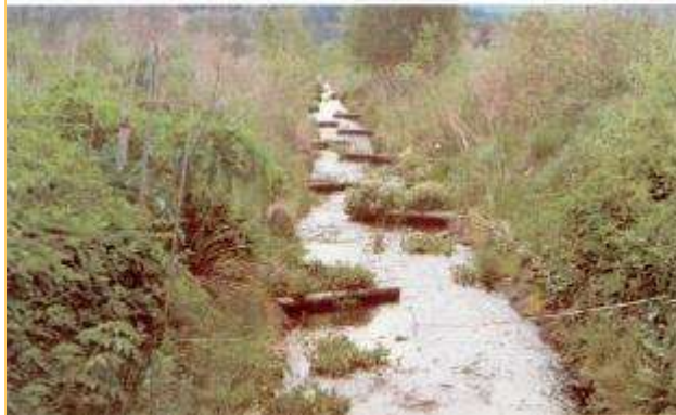
Usměrňovací výhony z tyčoviny po výstavbě a po dvouletém provozu
