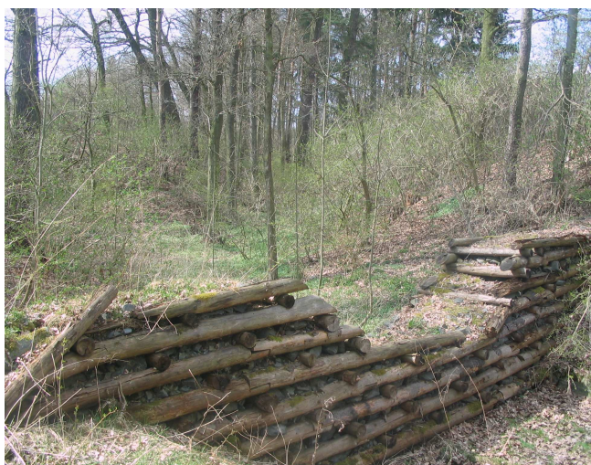
Obr. 6.15. Srubová přehrážka z dřeva a kameniva se zpevněným dopadištěm ve strži u obce Spáňov (Domažlicko) zadržuje vodu a snižuje odtok vody do obecní kanalizace.
