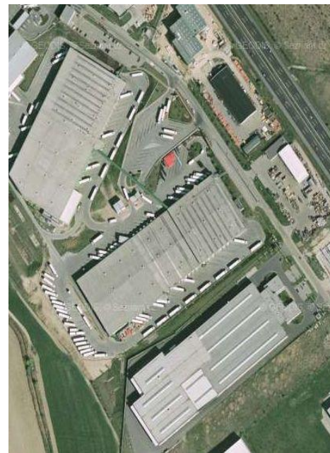
Letecký snímek dálnice D1
