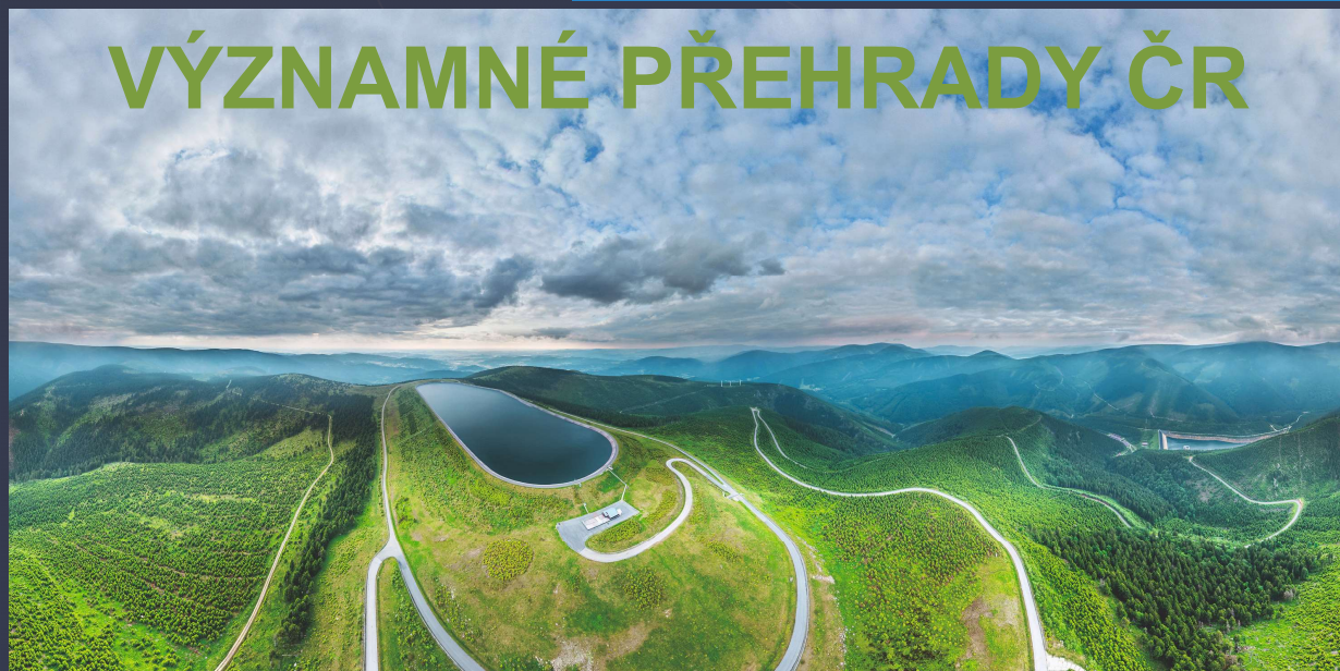
Přečerpávací vodní elektrárna a vodní dílo Dlouhé stráně – tok Divoká Desná
