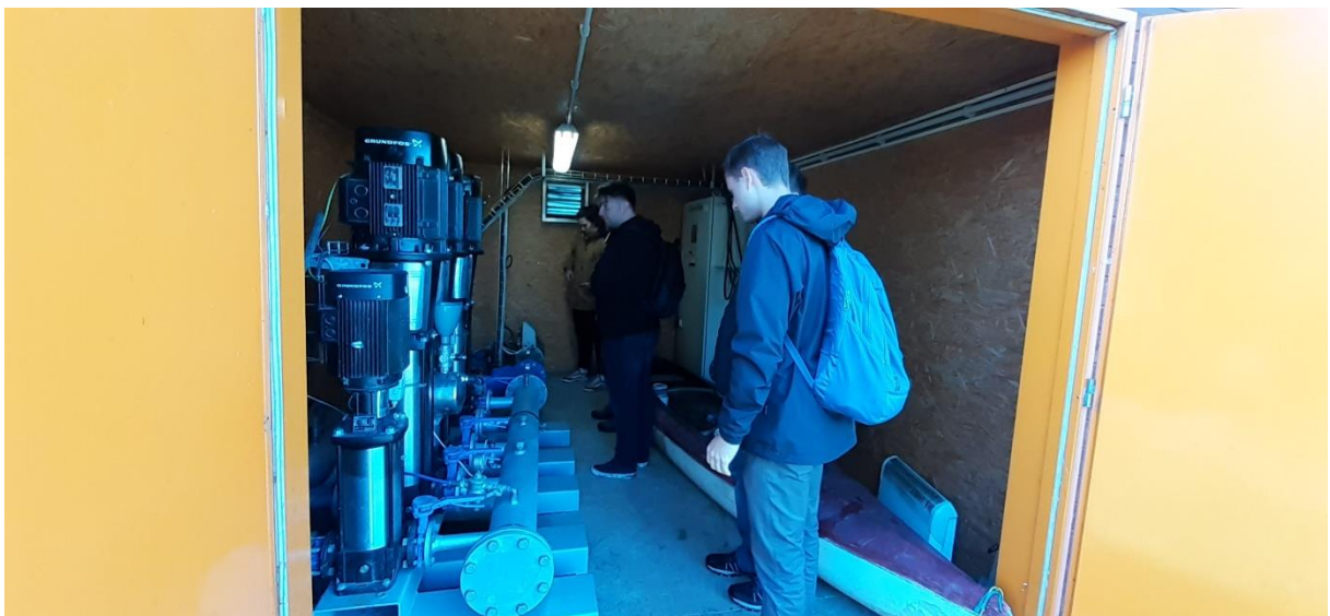
Obr. 15. Pohled do čerpací stanice závlahové vody.
