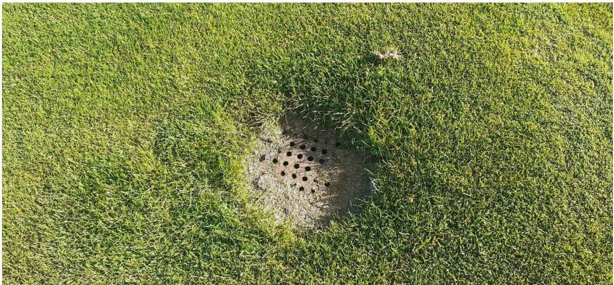
Obr. 13. Otvory pro vsak pro vody v terénních depresích. Podzemní drenáží je odváděna do centrální nádrže.
