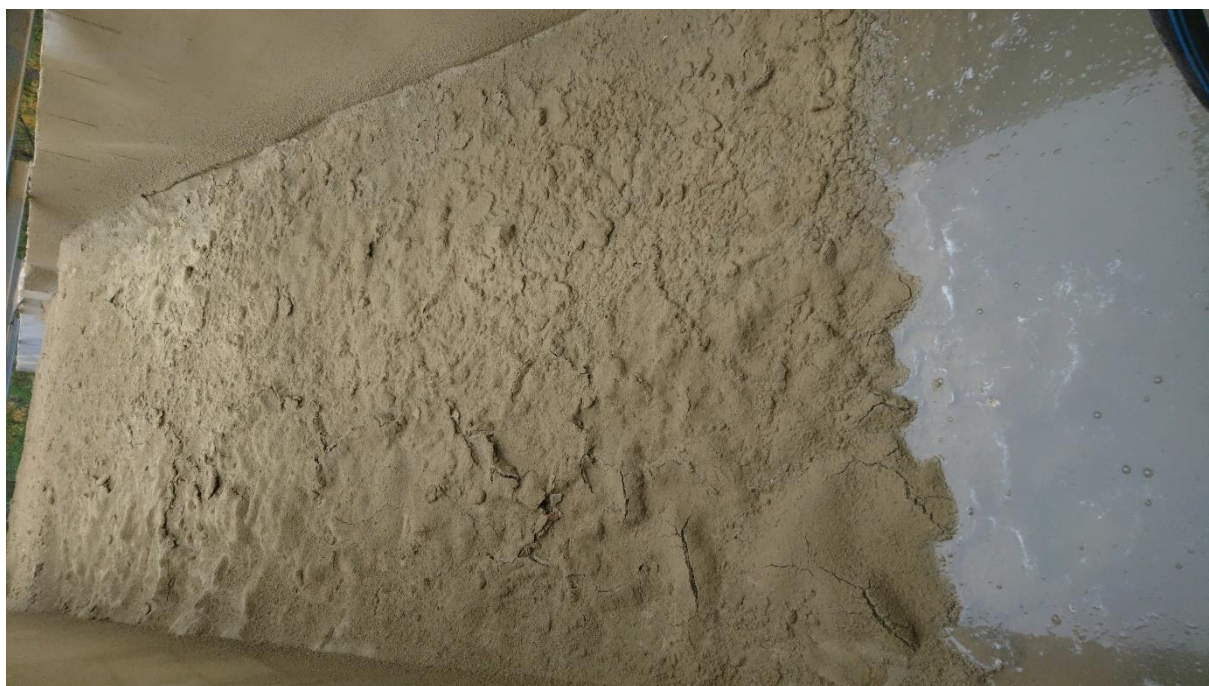
Obr. 3 Bentonitová těsnící vrstva nanesená na návodní líc experimentálního objektu
