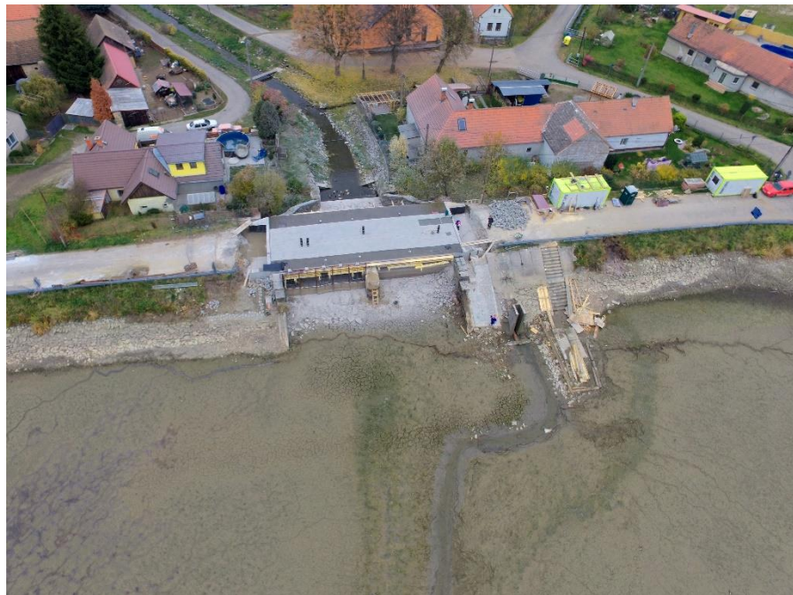
Obr. 16 Po povodni v roce 2013 byla provedena rekonstrukce bezpečnostního přelivu Popovického rybníka a mostu vedoucího přes něj.
