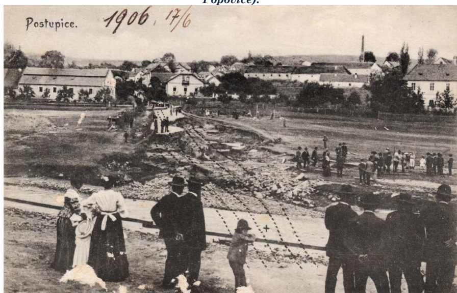
Obr. 15 Následky povodně z roku 1906 v Postupicích na dobové pohlednici.
