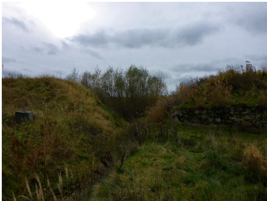
Obr. 9 Průrva v hrázi Mlékovického rybníka a stav vegetace v prostoru zátopy čtyři roky po protržení (stav v roce 2017).
