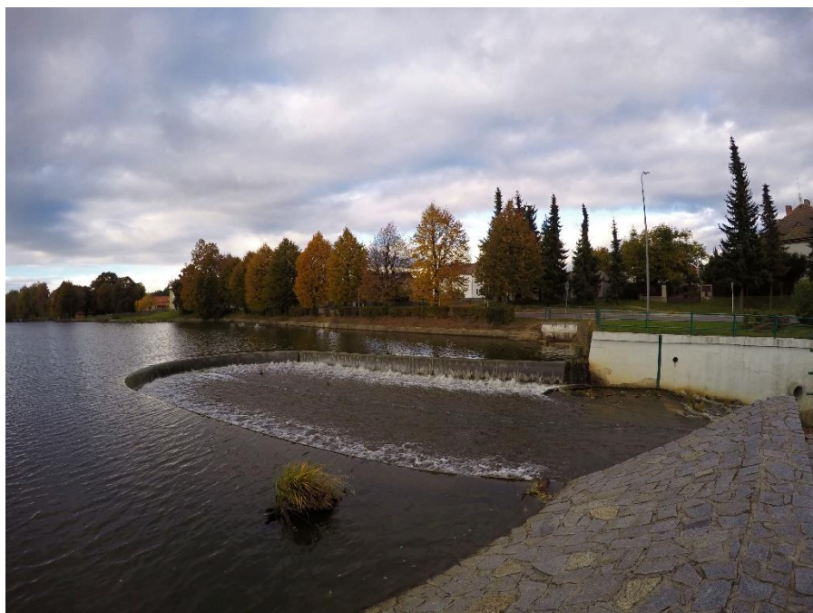
Obr. 21 Rybník Pustý v Blatné byl po povodni z roku 2002 zrekonstruován a vybaven novým kašnovým přelivem.
