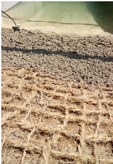
Obr. 7 Kokosová rohož jako ochrana bentonitové těsnicí vrstvy. Vlevo detail spojení rohože a těsnícího materiálu. Vpravo vyobrazen celek rohože a těsnicí vrstvy
