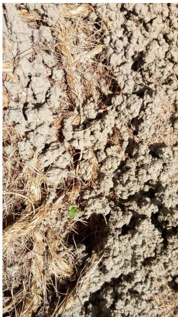
Obr. 7 Kokosová rohož jako ochrana bentonitové těsnicí vrstvy. Vlevo detail spojení rohože a těsnícího materiálu. Vpravo vyobrazen celek rohože a těsnicí vrstvy
