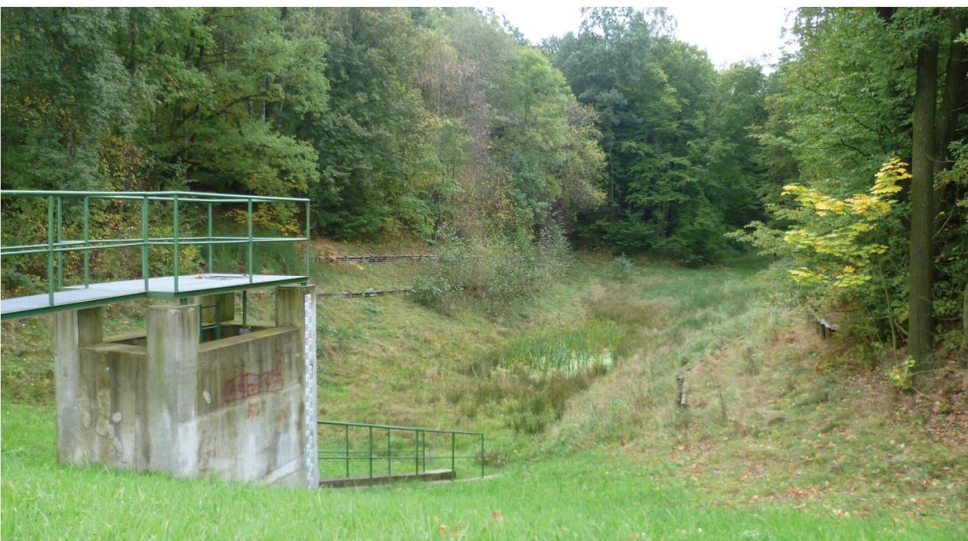
Obrázek 3: Sedimentační jímka
