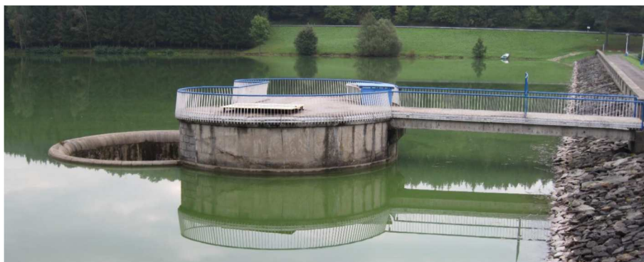
Obr. 8: Pohled na přeliv a hráz VD Ludkovice
