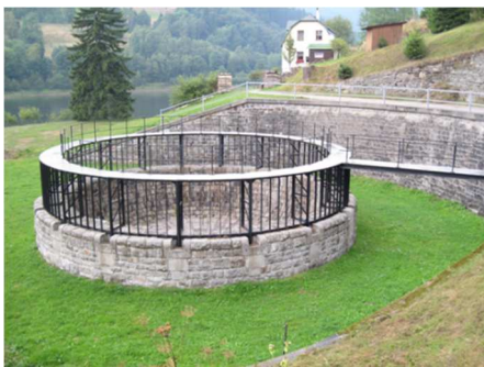
Obr. 1: Šachtový bezpečnostní přeliv na VD Labská
