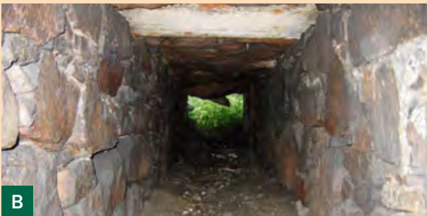
Obr. 6.8 případová studie: Speciální bariéra k zamezení mortality užovky stromové v Poohří. (© Radka Musilová)
