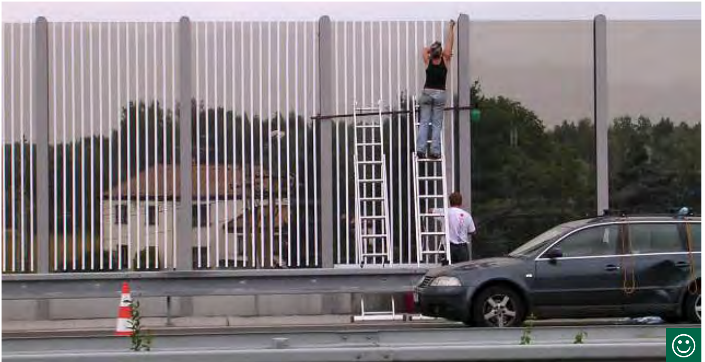
Obr. 10.56 Instalace svislých pruhů nalepením na PHS na dálnici D47 v České republice. V roce 2008 bylo na úseku pouhého 1 km této dálnice mezi Bohumínem a Ostravou nalezeno téměř 200 mrtvých ptáků během 6 měsíců. Po instalaci svislých pruhů klesla mortalita prakticky na nulu. (© Jan Mayer)
