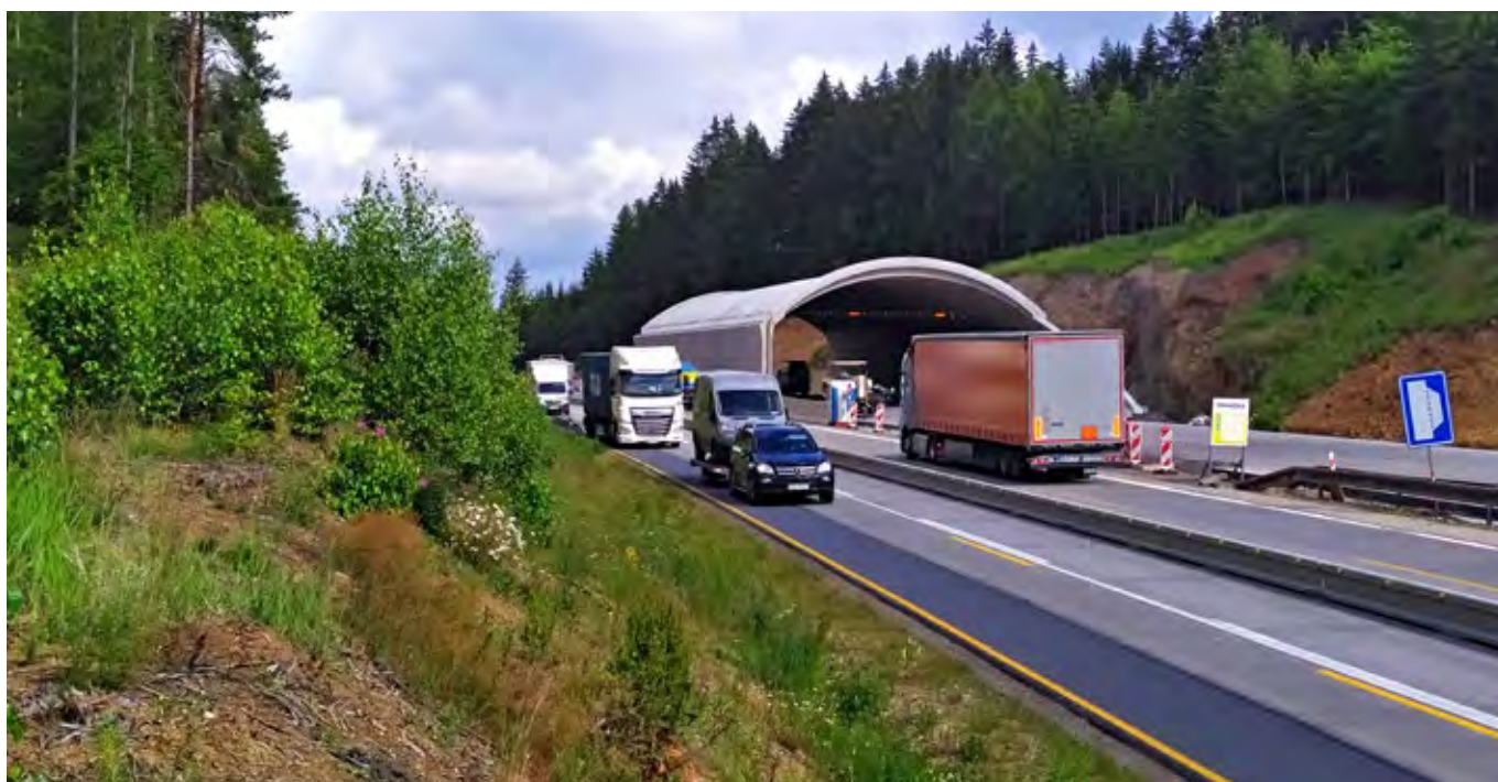
Obr. 8.8 Zelený most východně od Humpolce budovaný v rámci modernizace D1 za plného provozu. (© Václav Hlaváč)
