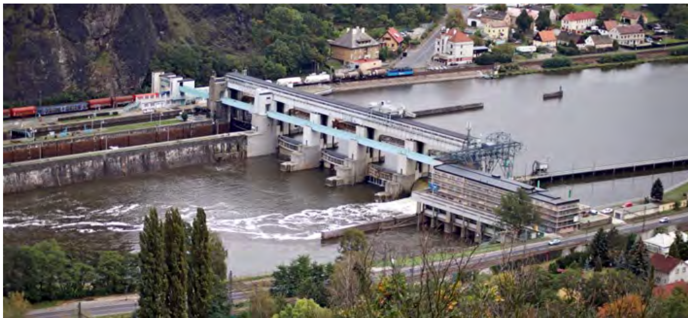
Obr. 6.21 Masarykova zdymadla v Ústí nad Labem. Jez v kombinaci se svislým opevněním na obou březích vodního toku nutí zvířata, jako jsou vydra nebo bobr, tyto překážky obcházet a překonávat tak rizikovou silnici a železnici, které se nacházejí na obou březích Labe. (© Petr Mička)
