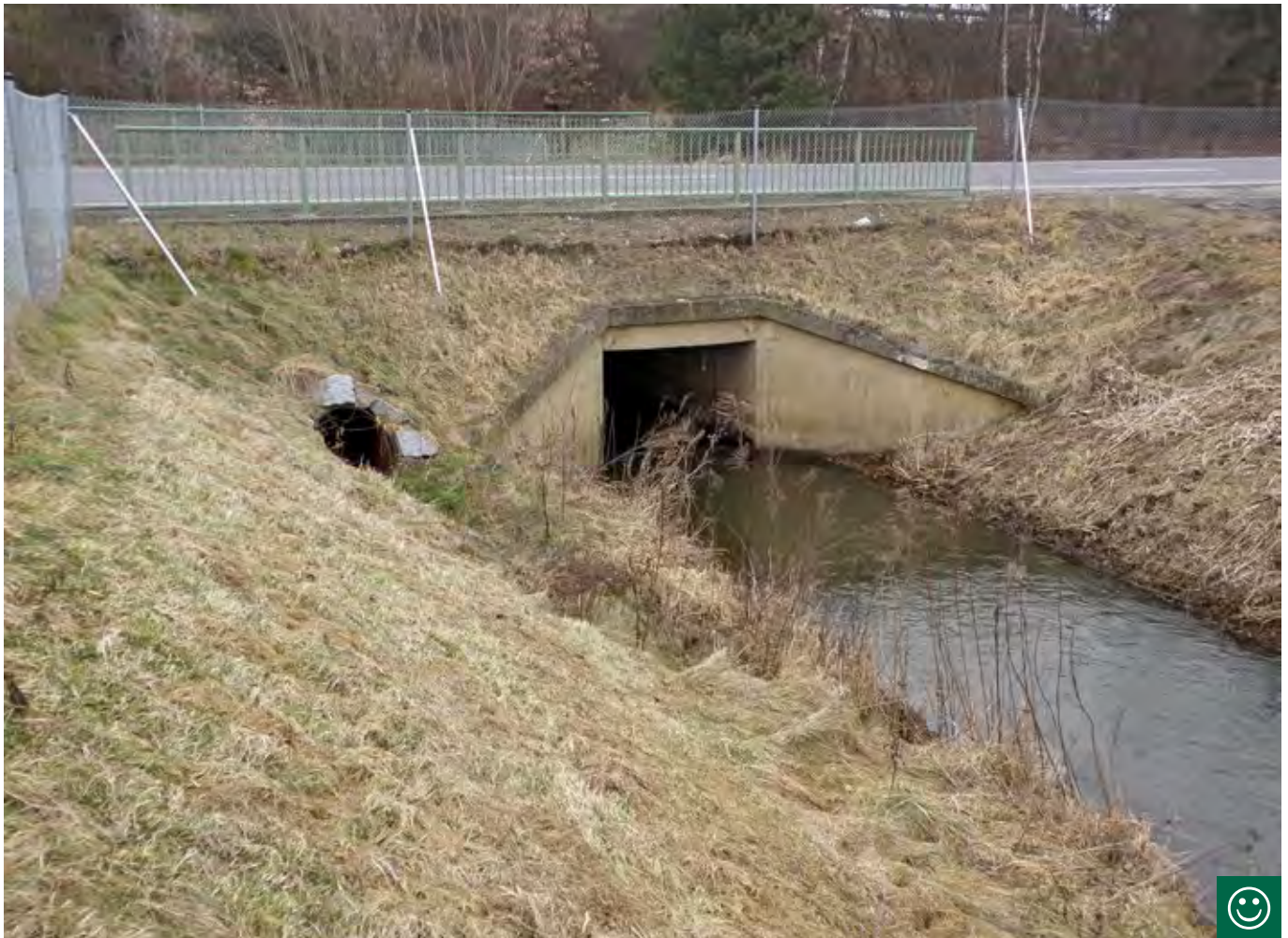
Obr. 10.81 Pokud není možné nevhodný most upravit tak, aby plnil funkci průchodu pro dané druhy, může být v jeho blízkosti dodatečně vybudován souběžný vydří tunel. Pro lepší navedení živočichů k otvoru průchodu se doporučuje vhodná modelace terénu a použití naváděcích bariér. (© Lukáš Poledník)
