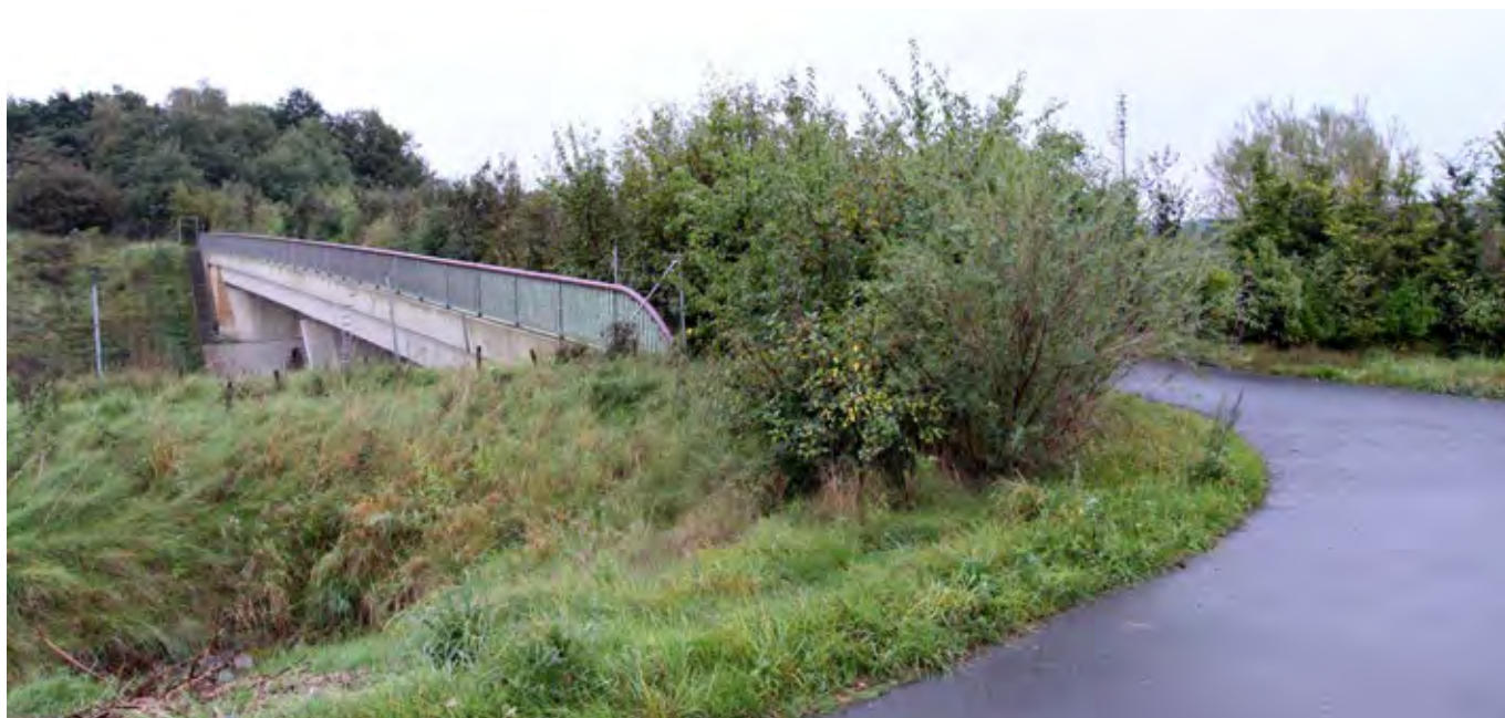
Obr. 6.24 Lesní cesta přes dálnici rozšířená o pruhy s keři po obou stranách umožňuje propojení lesního prostředí pro mnoho druhů živočichů, včetně savců žijících na stromech, drobného ptactva nebo netopýrů. Představuje velmi dostupné opatření s výrazným efektem. Drážďany, Německo. (© Václav Hlaváč)
