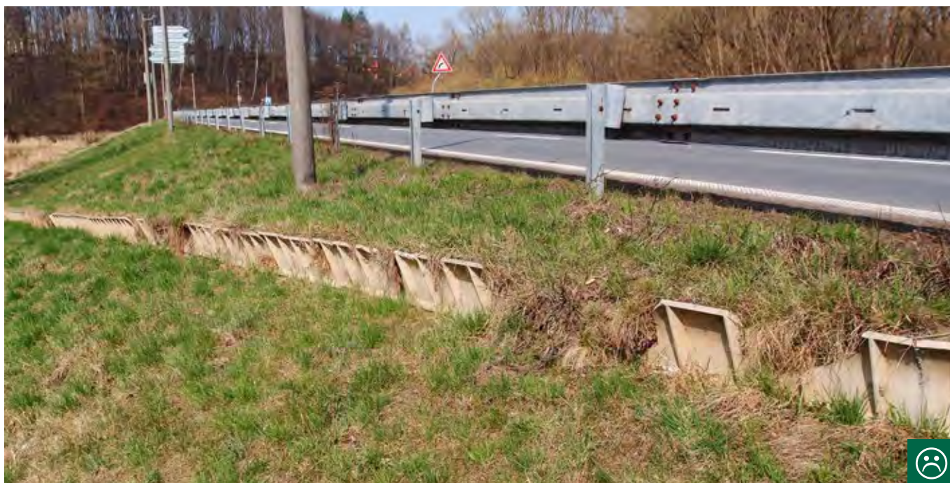
Obr. 10.73 Pokud nejsou trvalé zábrany průběžně udržované, rychle ztrácejí svoji funkci. (© Petr Vlček) ☹
