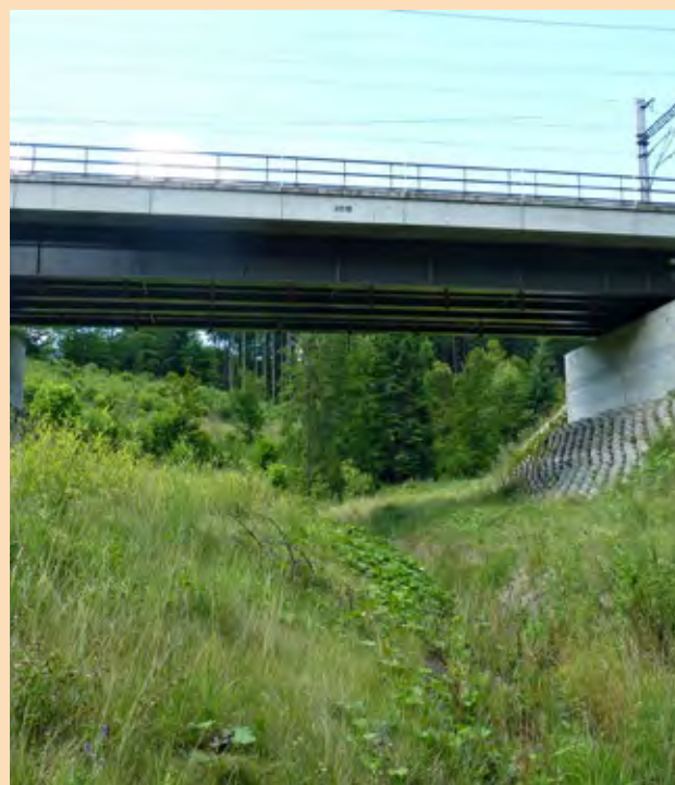
Obr. Dokončené zkapacitnění podchodu v parametrech využitelnosti pro velké savce v Mostech u Jablunkova poblíž státní hranice (stav 2017).
