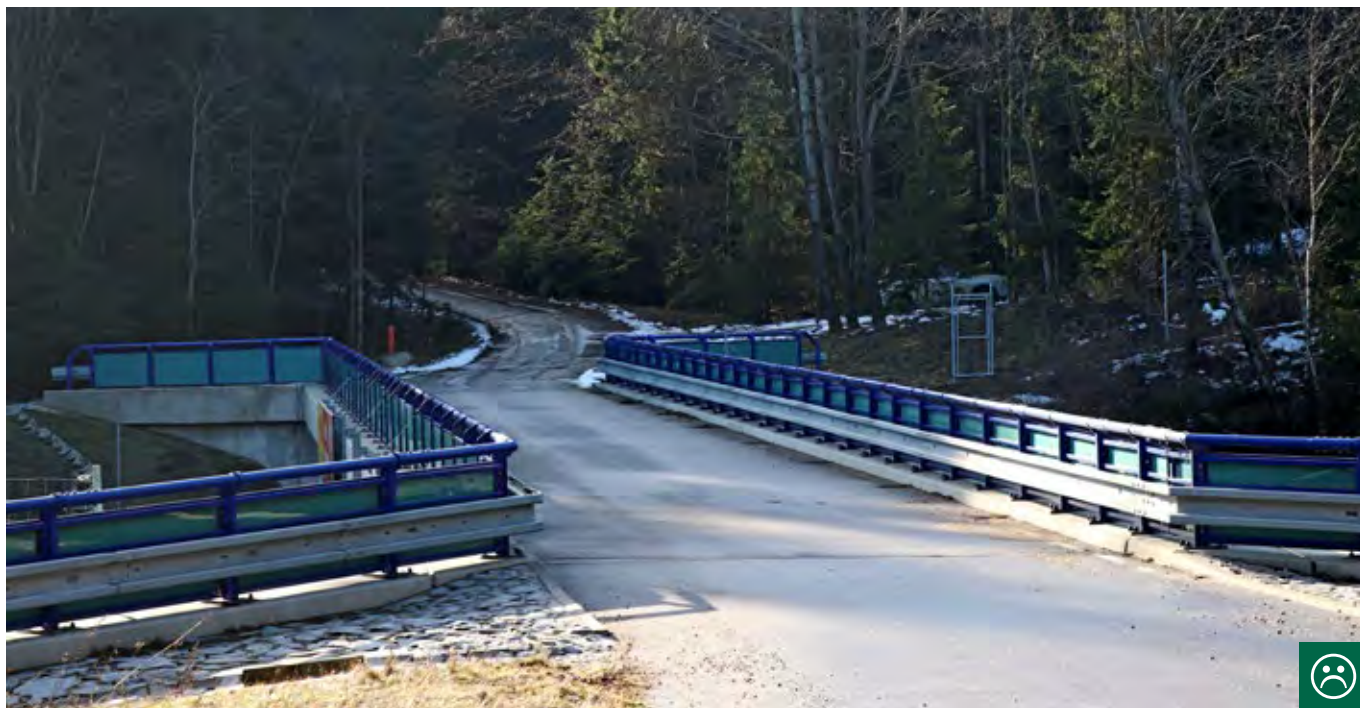
Obr. 10.4 Na tomto mostě převádějícím lesní cestu přes dálnici D1 bylo pro eliminaci rušivých vlivů nainstalováno zábradlí s neprůhlednou výplní. Jelikož je ale asfaltový povrch pro pohyb zvířat nevhodný, most není živočichy využíván. (© Václav Hlaváč)
