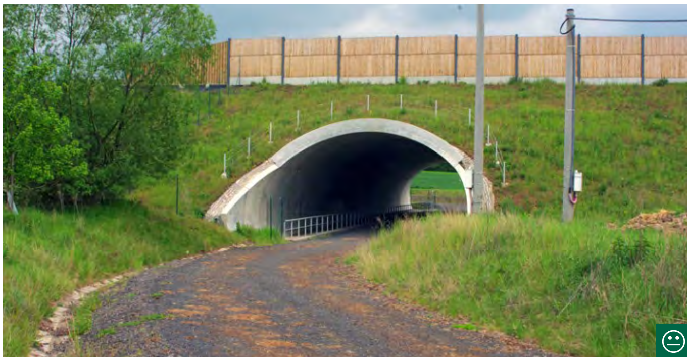
Obr. 10.76 Přesypaný most přes obslužnou komunikaci, navíc vybavený ochrannou stěnou. Z obou stran je napojen na liniovou vegetaci. Most o světlé výšce 3,5 m využívá řada nízko létajících druhů. (© Tomáš Bartonička)
