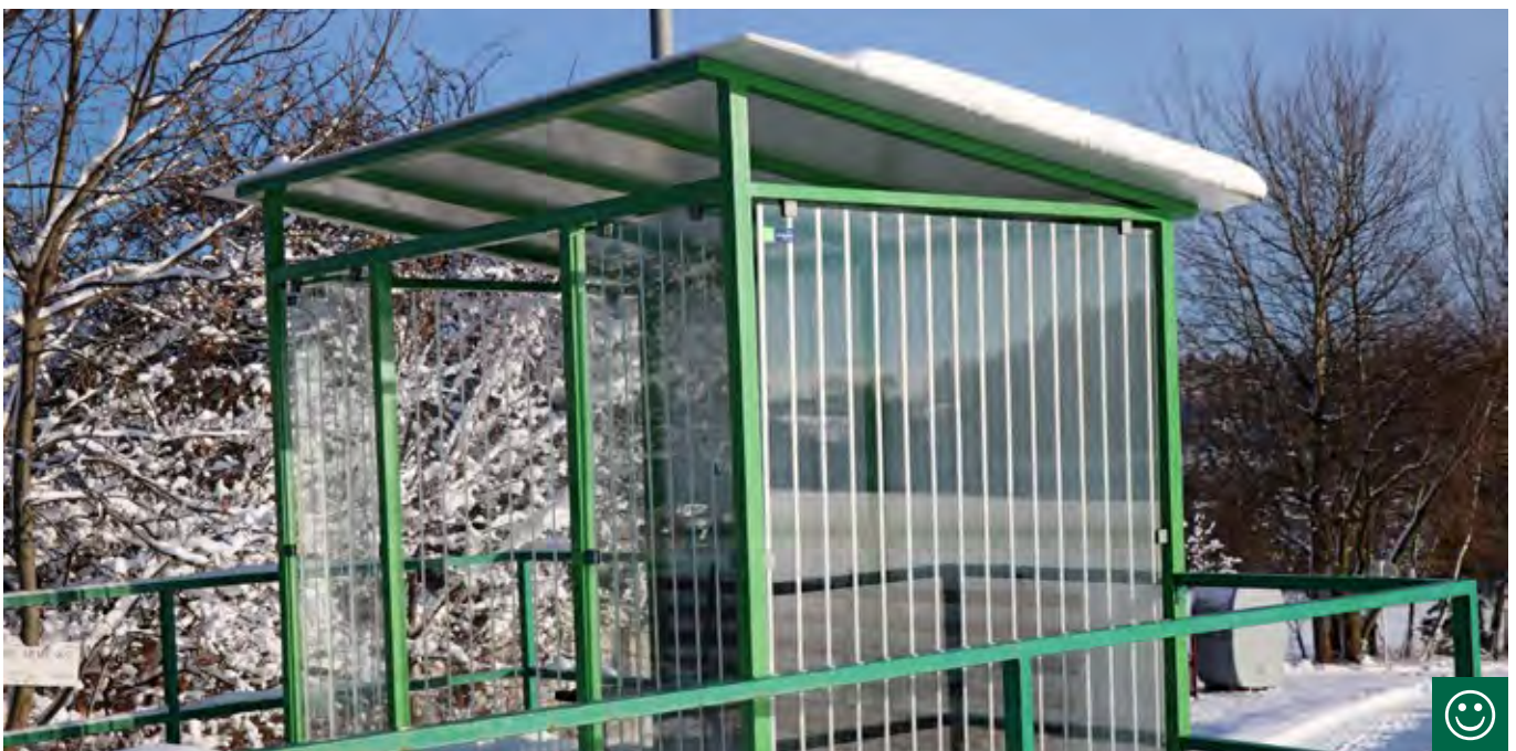
Obr. 10.57 Vysokou mortalitu ptáků můžeme zaregistrovat nejen u průhledných protihlukových stěn, ale též u autobusových zastávek. Zabezpečení proti nárazům je v obou případech obdobné. (© Václav Hlaváč)
