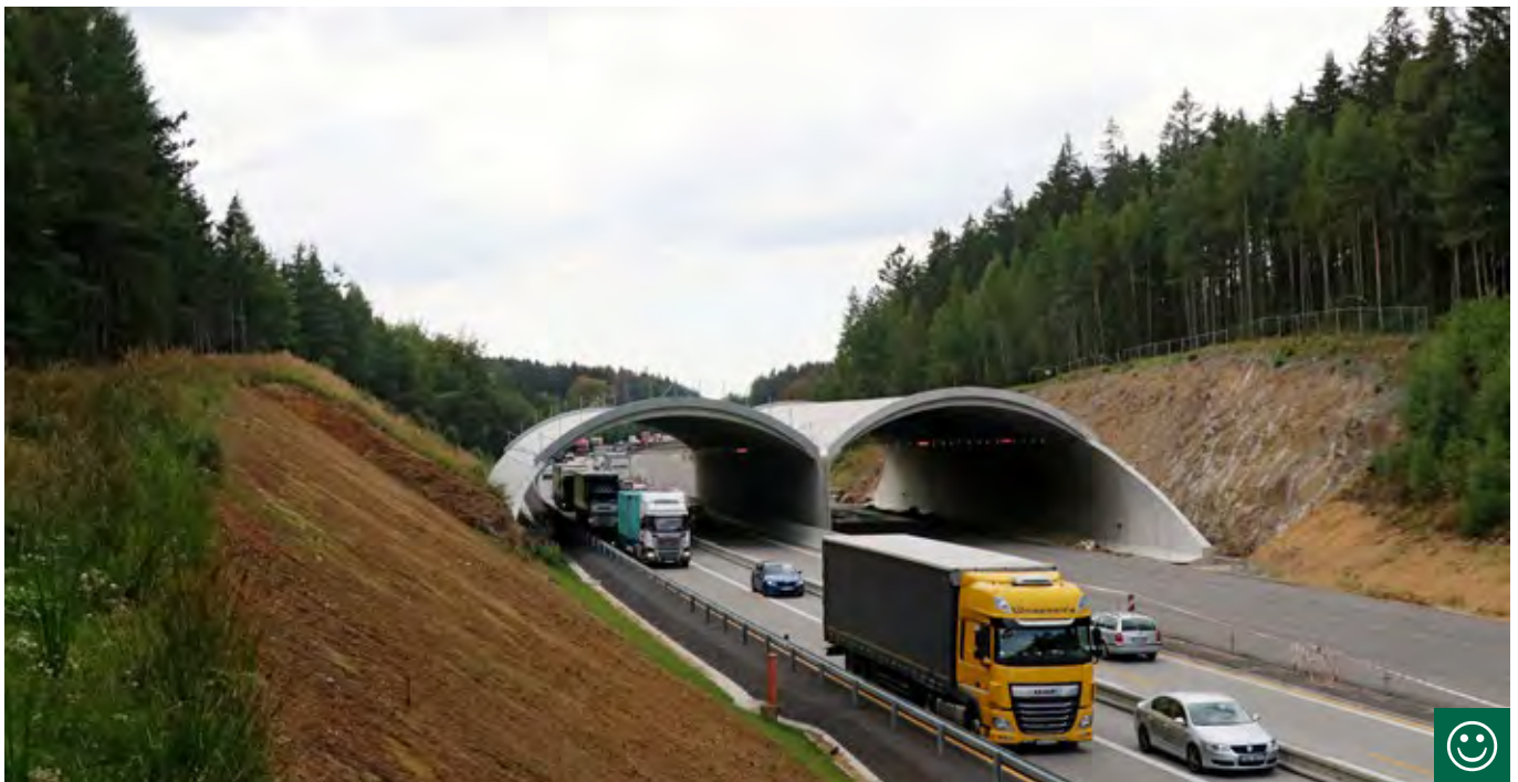
Obr. 10.11 Zelený most v místě, kde dálnice D1 kříží významný migrační koridor velkých savců, byl budován v rámci modernizace D1 za provozu. (© Václav Hlaváč)
