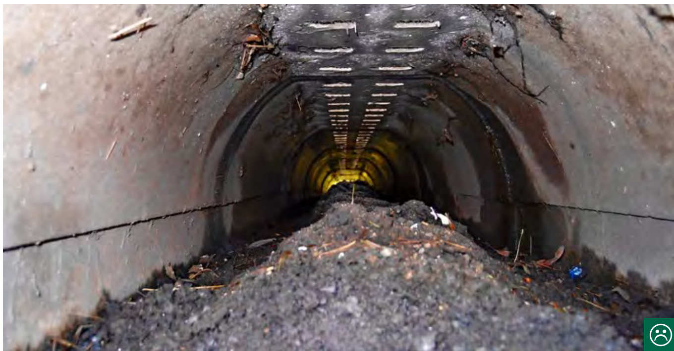
Obr. 10.68 Častým problémem tunelů pro obojživelníky je absence údržby. Zbytky po zimním posypu komunikace mohou v krátké době vyplnit celý profil průchodu. (© Petr Vlček)
