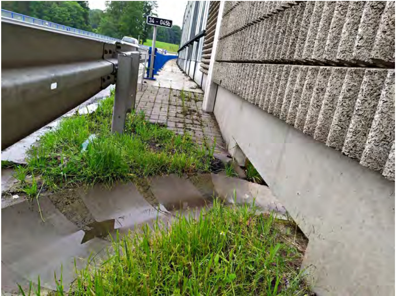
Obr. 10.59 Prostor pro odtok vody ze silnice pod protihlukovou stěnou vytváří průchod pro živočichy do velikosti jezevce či lišky. Otvor umožňuje živočichům opustit silnici, může být však využitý také opačným směrem. Měl by být proto opatřen zařízením umožňujícím jednosměrný průchod, nebo (u méně frekventovaných silnic) by měl být zajištěn stejný průchod i na opačné straně. (© Václav Hlaváč)
