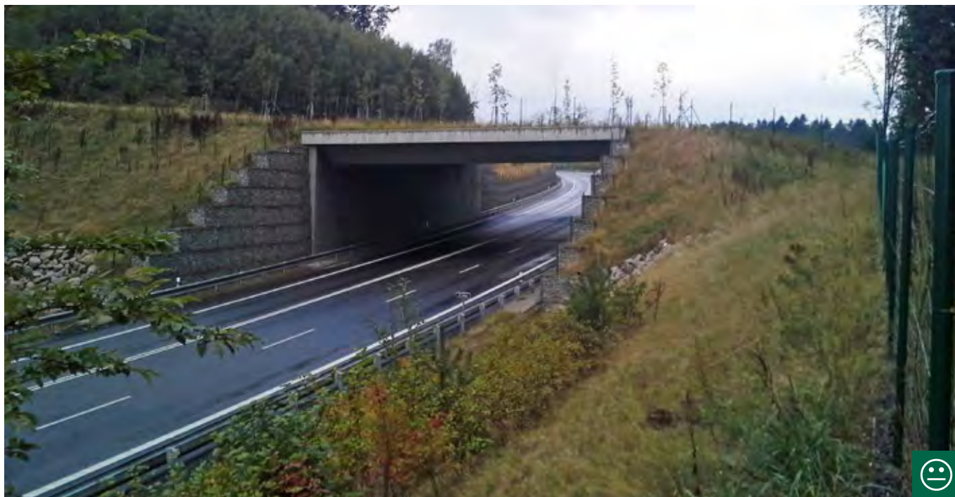
Obr. 10.16 V případech, kdy silnice I. třídy kříží migrační koridor velkých savců, je vhodným řešením zelený most. V tomto případě by účinnost mohla být dále zvýšena instalací ochranných stěn napojených na naváděcí oplocení. (© Tomáš Benda)
