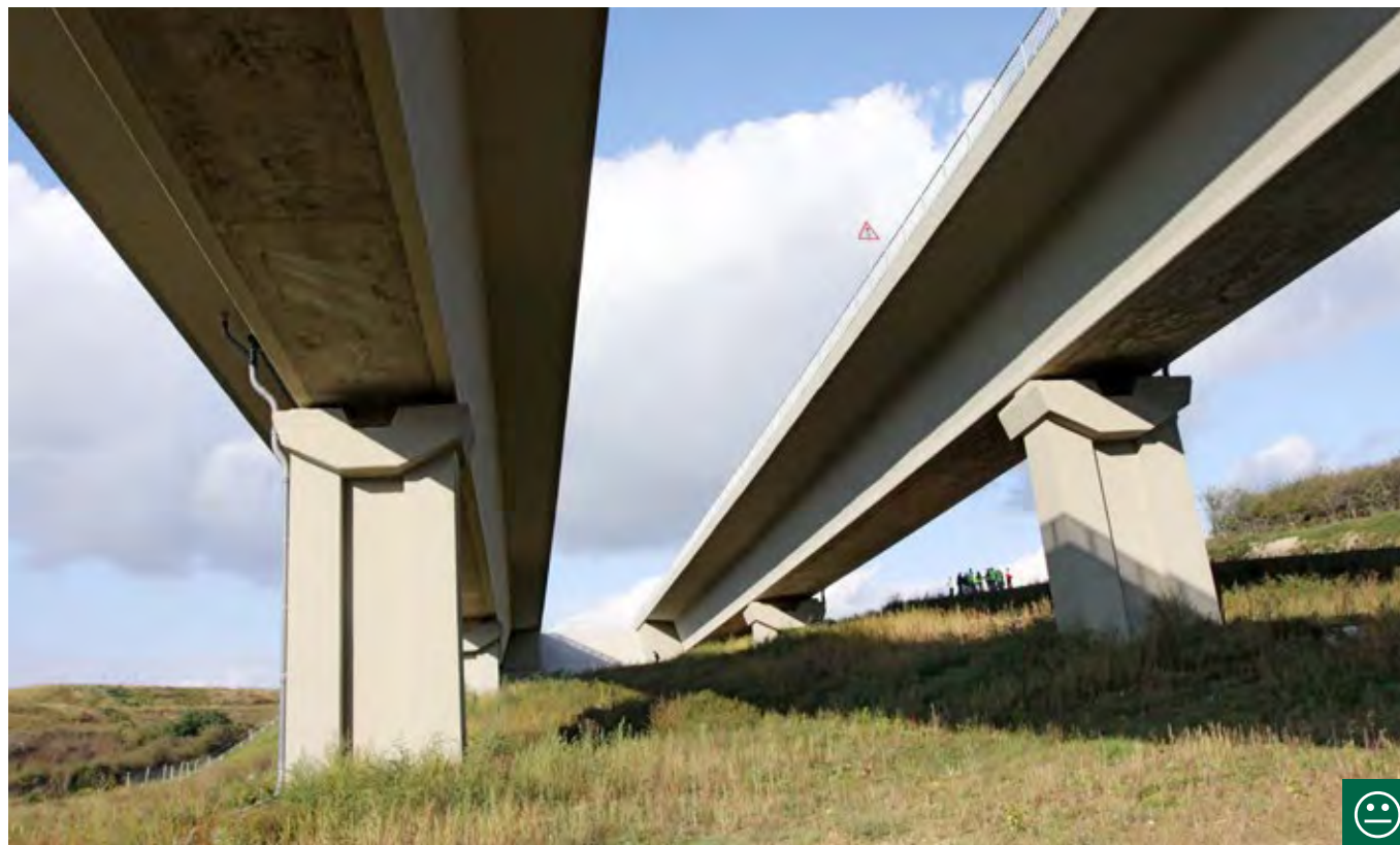
Obr. 10.41 Rozdělení konstrukce na dva samostatné mosty zajišťuje v podmostí dostatek světla a srážek pro růst vegetace. Takovéto technické řešení usnadní lepší propojení biotopů. V porovnání se spojenou konstrukcí však znamená větší šířku ovlivněného území a intenzivnější rušení hlukem při průchodu pod mostem. (© Václav Hlaváč)
