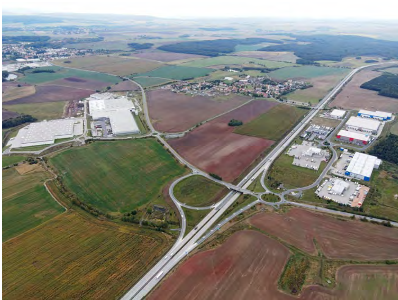
Obr. 4.10 Nová dopravní infrastruktura často přináší do dané oblasti další výstavbu. Výstavba logistického centra u dálnice D5 u obce Nýřany. (© Archiv DES OP Plzeň)
