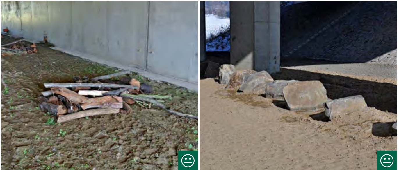
Obr. 10.23 Úkryty pro drobné živočichy výrazně zvyšují využitelnost podchodů pro drobné savce, plazy i obojživelníky. U těchto mostů by však bylo vhodné využít kombinace materiálů a jednotlivé úkryty vzájemně propojit. (© Vlastimil Bogdan)
