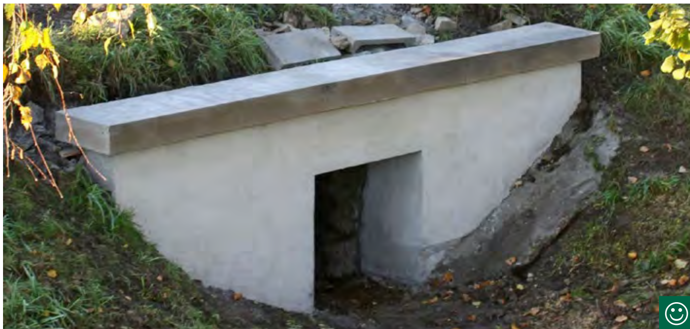
Obr. 10.31 V porovnání s trubním propustkem je rámový propustek řešením, které umožňuje migraci širšího spektra živočichů. (© Václav Hlaváč)
