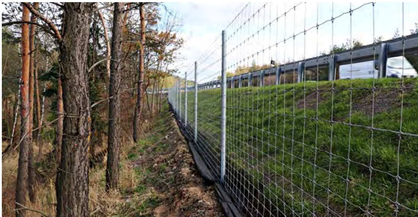
Obr. 8.7 Oplocení budované dodatečně podél existující komunikace vždy zvyšuje její bariérový účinek. Při plánování nového oplocení je proto nutné se zabývat také otázkou průchodnosti komunikace a případně navrhnout odpovídající zprůchodňující opatření. (© Václav Hlaváč)
