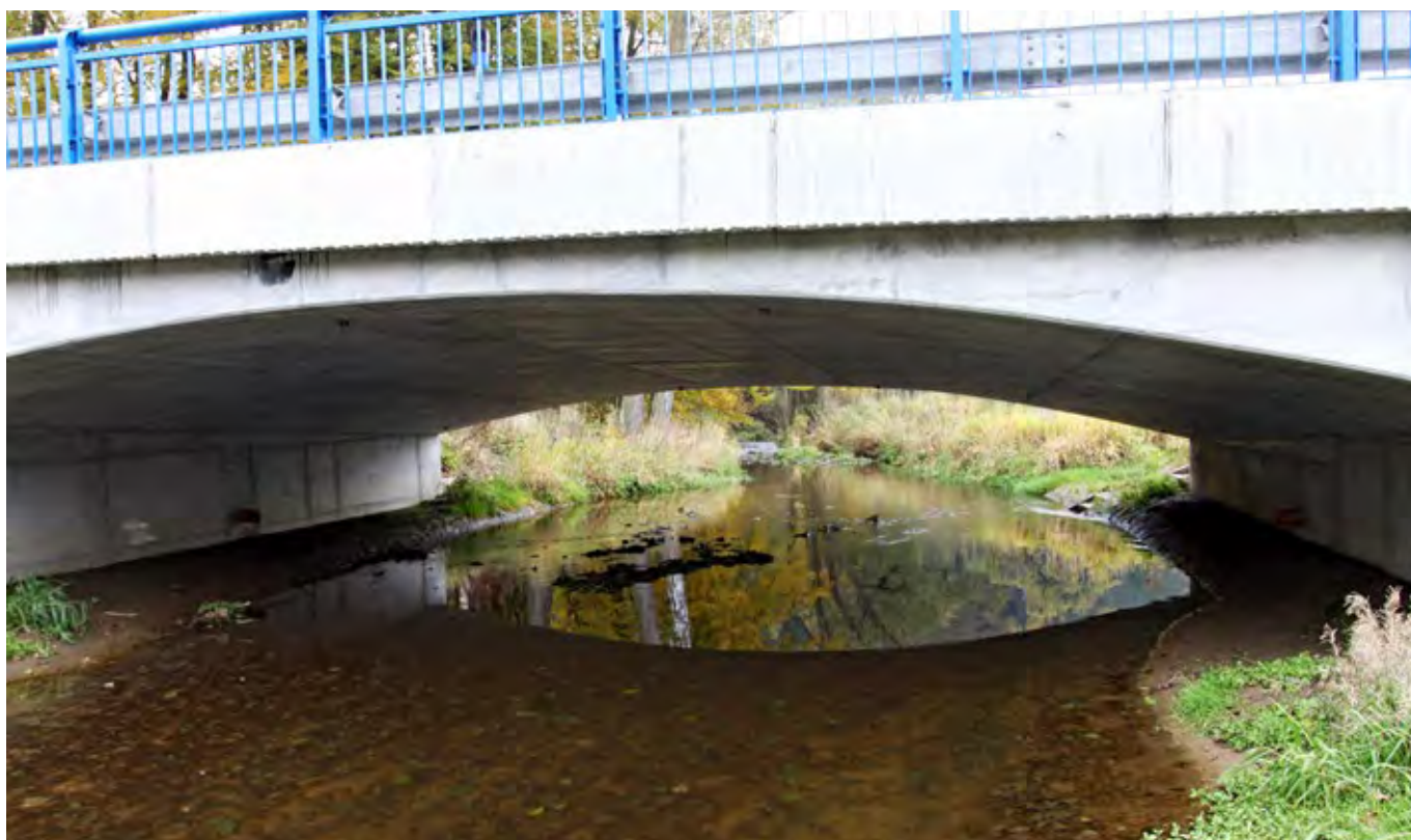
Obr. 6.13 Ptáci jako ledňáček říční, skorec vodní či konipas horský jsou schopni proletět pod mostem s indexem otevřenosti min. 1,5. Důležitá je i výška, která by měla být min. 2 m. V případě mostů s menšími rozměry ptáci obvykle mosty přeletují vrchem a stávají se pak oběťmi dopravy. (© Václav Hlaváč)
