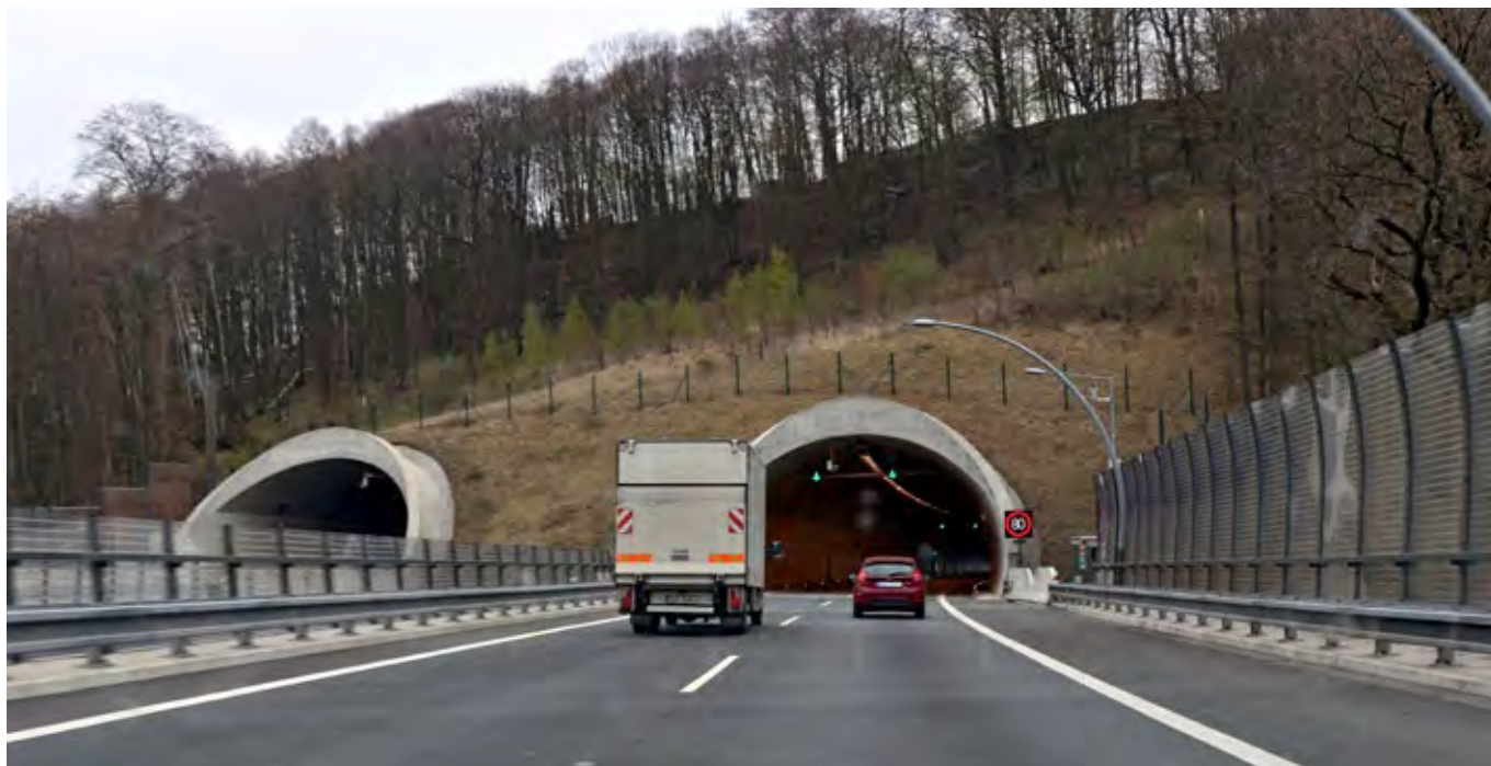
Obr. 9.6 V přírodně cenných oblastech je třeba nahrazovat hluboké zářezy tunelem. (© Václav Hlaváč)
