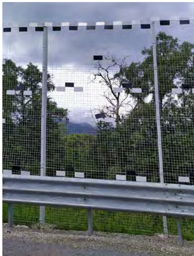
Obr. 6.11 Drátěná stěna vysoká 4,5 m představuje účinné řešení k zamezení mortality vodních ptáků (údolí Váhu, Slovensko) (© Václav Hlaváč)
