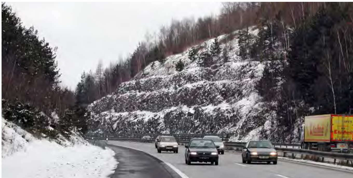
Obr. 9.9 Terasování stabilizuje svahy hlubokých zářezů a vytváří vhodná stanoviště pro různé druhy rostlin a živočichů. (© Václav Hlaváč)
