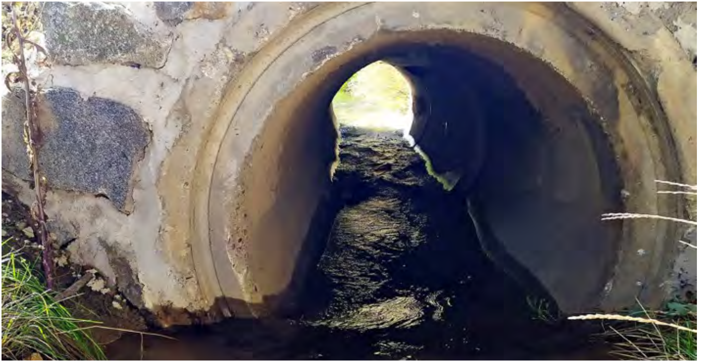
Obr. 10.25 Trubní propustky s trvalým průtokem vody jsou neprůchodné pro suchozemské živočichy i pro obojživelníky. Průchodnost pro ryby bude vždy limitovaná rychlostí protékající vody. (© Václav Hlaváč)
