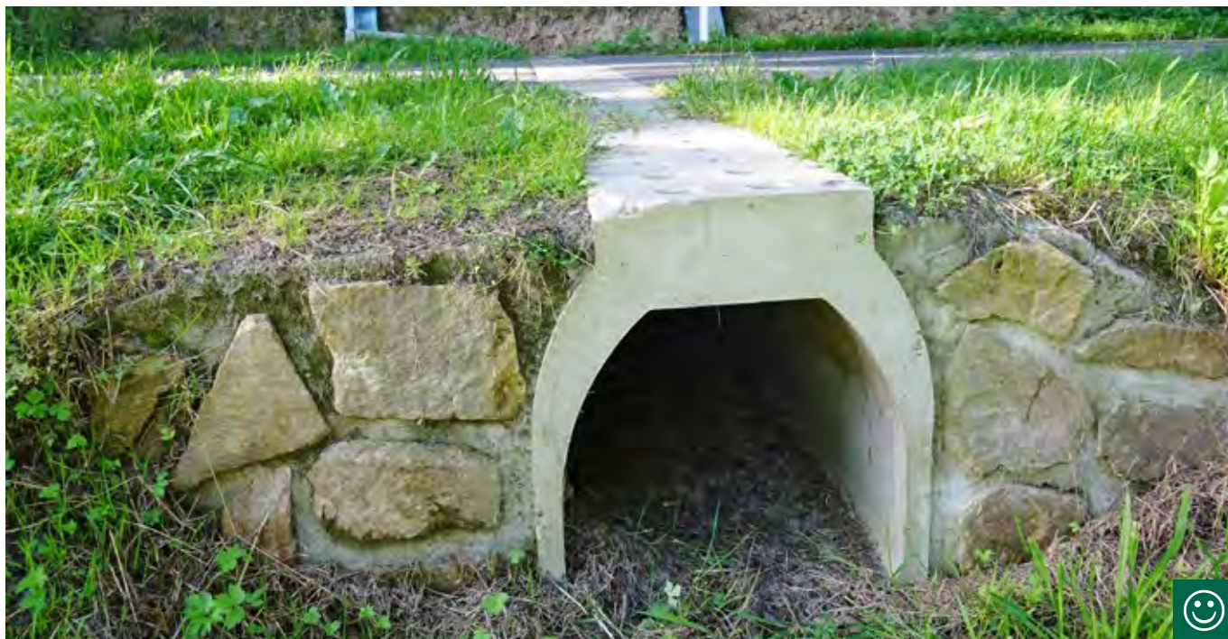
Obr. 10.67 Pokud neexistuje v místě významných migrací obojživelníků vhodný most nebo propustek, je možné dopravní infrastrukturu překonat speciálním průchodem, tzv. tunelem pro obojživelníky. (© Jitka Uhlíková)
