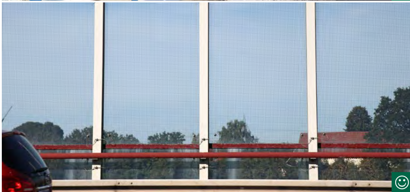
Obr. 10.55 Svislé pruhy nebo drátěná síť přímo ve stěně spolehlivě chrání ptáky před nárazy a zároveň představují přijatelná řešení z hlediska architektury. (© Václav Hlaváč)
