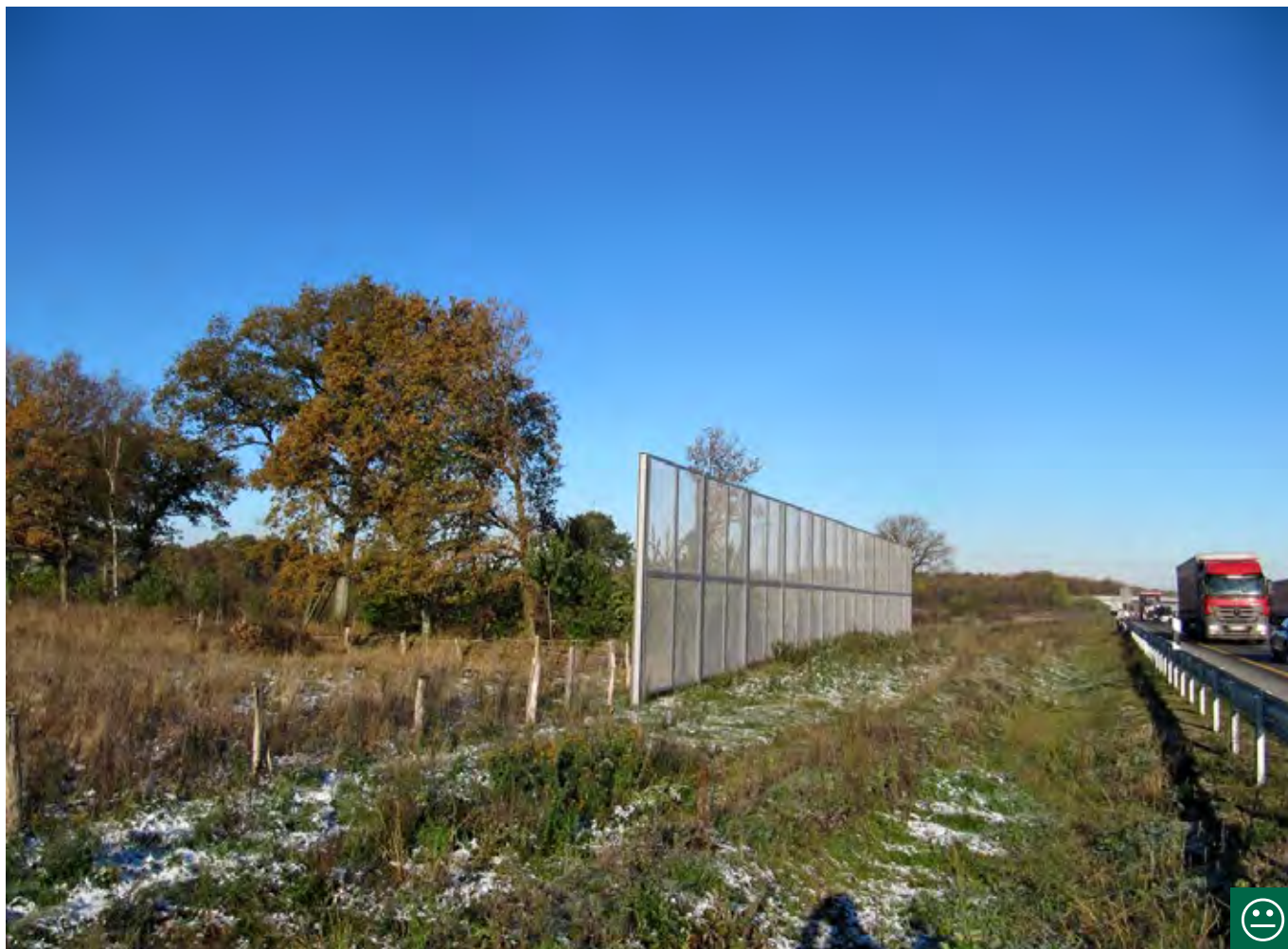
Obr. 10.79 Ochranné stěny jsou opatřením pouze v místech významných přeletových koridorů, a to s doloženým výskytem nízkolétajících druhů a druhů přeletujících ve středních výškách. Německo. (© Morten Elmeros)
