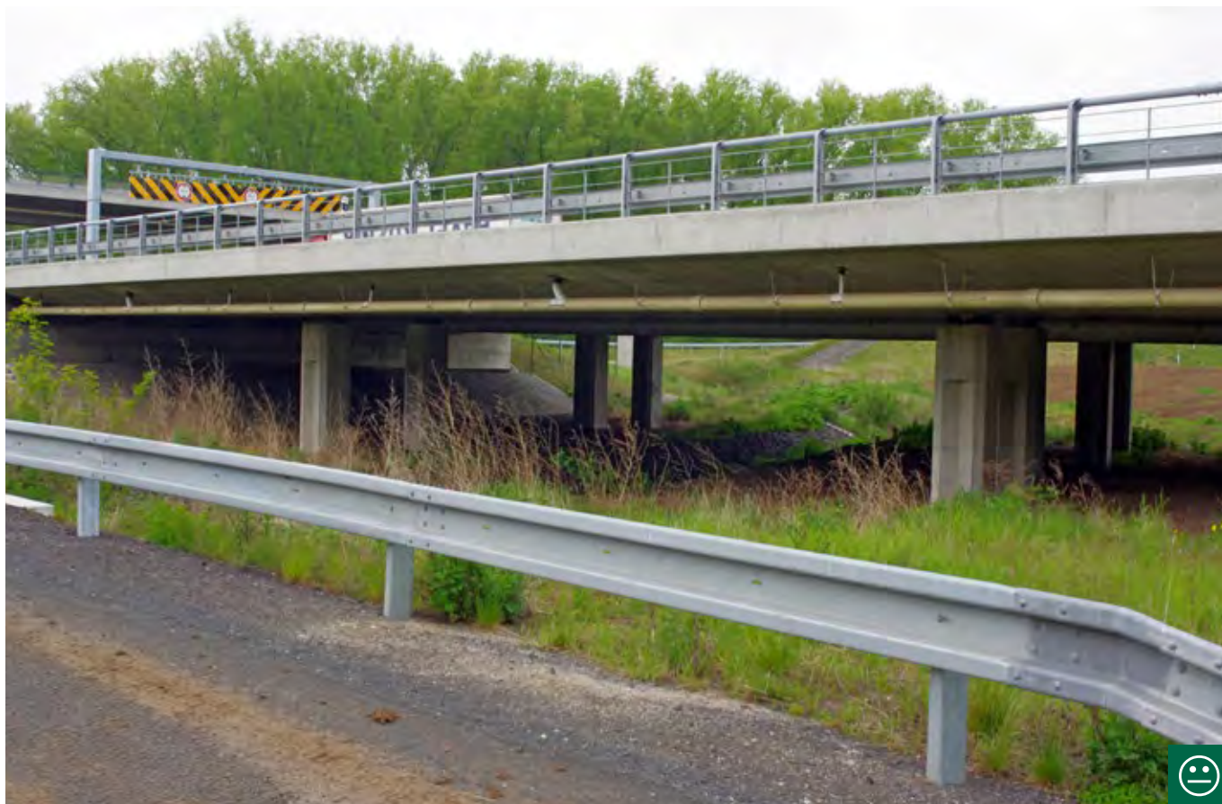
Obr. 10.75 Most o výšce 6 m je již dostatečný pro nízko létající druhy i druhy přeletující ve středních výškách. Zde pod mostem navíc probíhá drobná vodoteč a most navazuje na obou stranách dálnice na porostní okraje. Jedinou komplikací mohou být další křížení koridoru s obslužnými komunikacemi. Zde však s minimálním provozem. (© Tomáš Bartonička)
