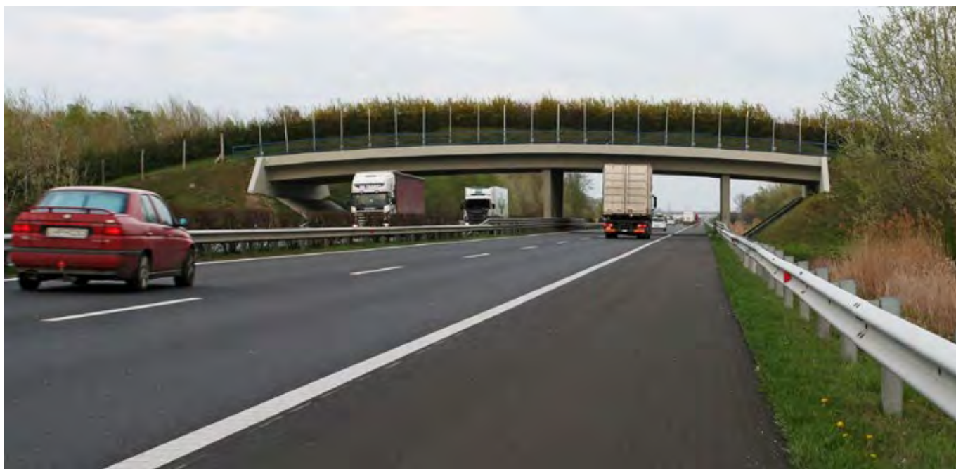
Obr. 6.55 V případě, že je v nížinné zemědělské krajině identifikován migrační koridor velkých savců, je nutné zde zajistit odpovídající průchodnost - například vybudováním zeleného mostu. (© Václav Hlaváč)
