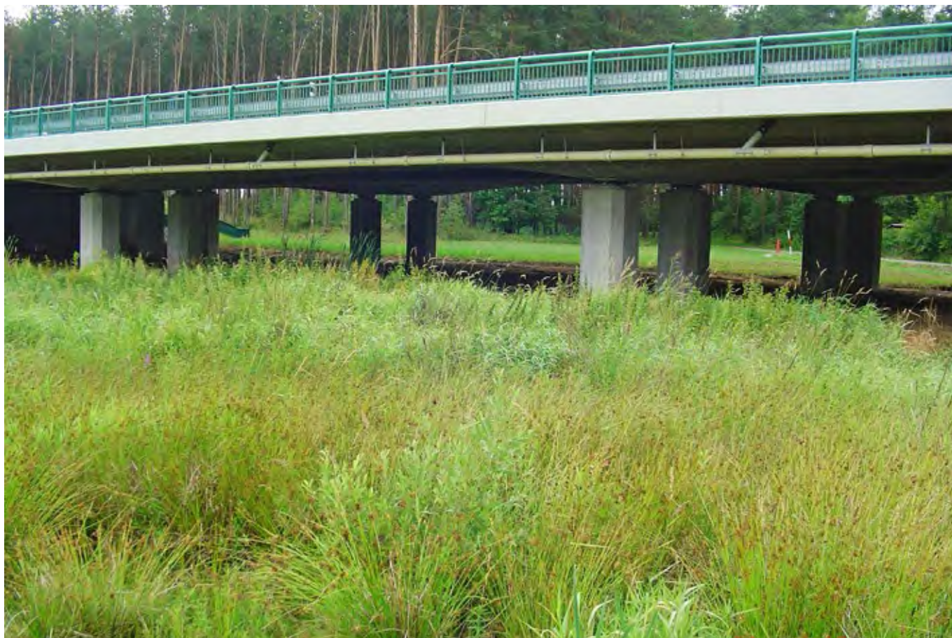
Obr. 6.46 Estakáda na dálnici D3 u obce Žišov byla vybudována pro překonání mokřadů a tůň s výskytem piskoře pruhovaného. (© Jana Kloubcová)
