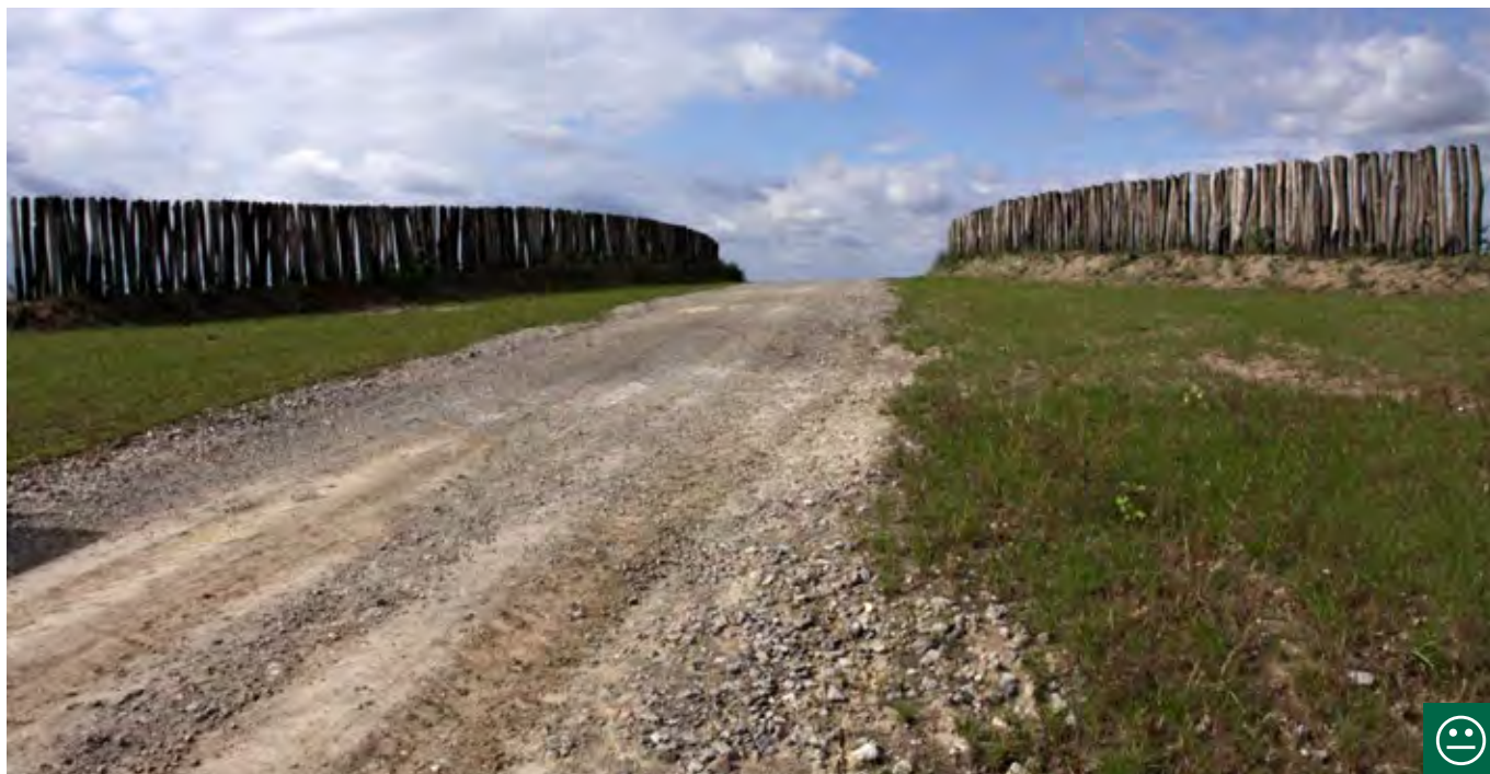
Obr. 10.12 Takovýto víceúčelový nadchod má pro volně žijící živočichy pouze omezené využití. Chybí zde úkrytové možnosti (keře). Potřeba úkrytů je o to vyšší z toho důvodu, že zvířata nevidí bezpečnou krajinu na druhé straně nadchodu. (© Václav Hlaváč)
