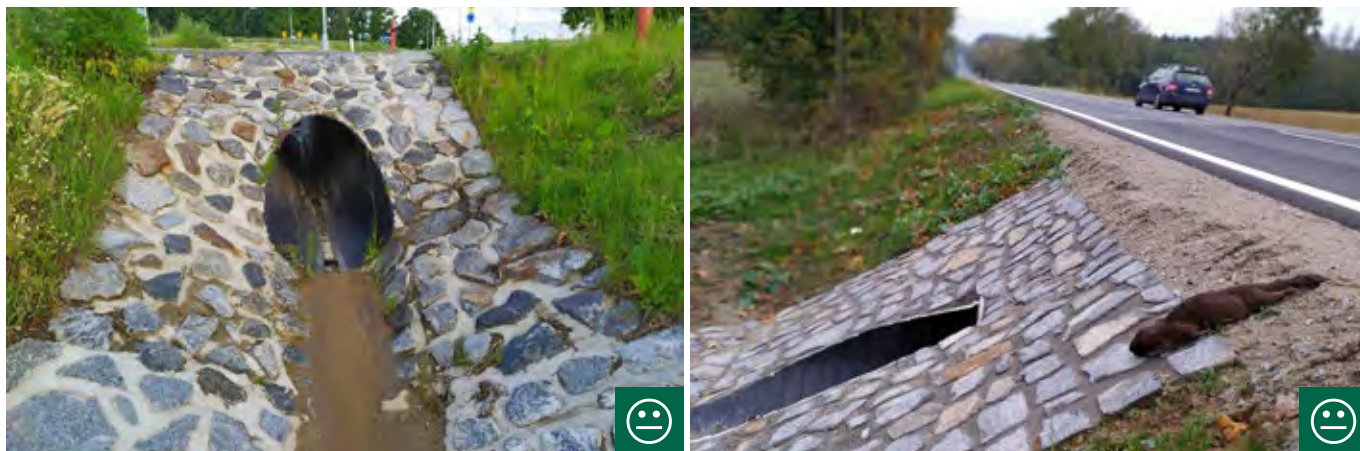
Obr. 10.27 S využíváním plastových propustků zvířaty nejsou dosud dostatečné zkušenosti. Nález přejeté vydry dokládá, že novým propustkům vydra nedůvěřuje a přechází silnici vrchem. Je však možné, že pokud po čase dojde k překrytí dna splaveninami, může být propustek využíván obojživelníky i drobnými savci. (© Václav Hlaváč)
