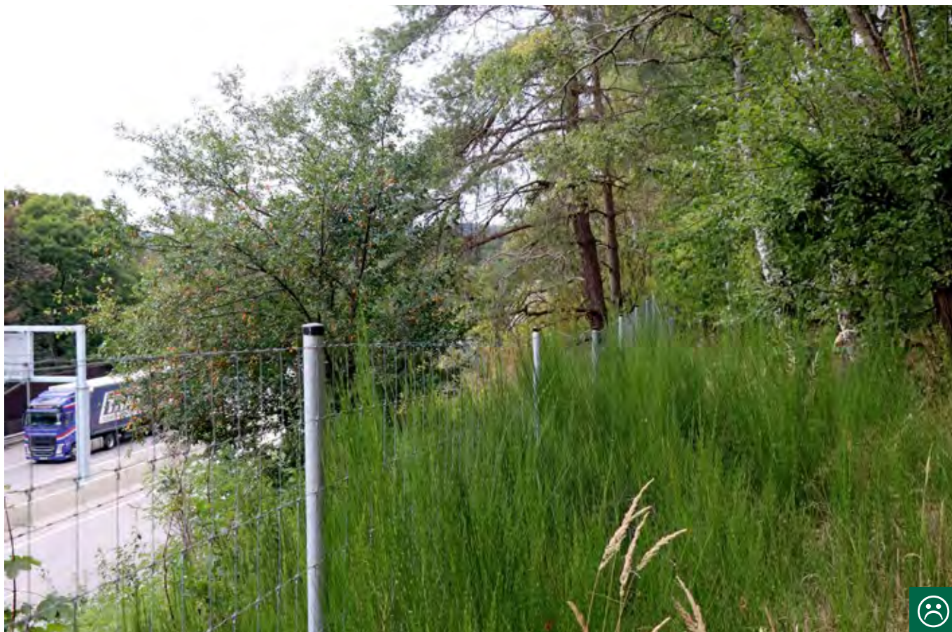
Obr. 10.51 Pokud je oplocení vedeno stromovým porostem daleko od dálnice, zvířata mají dostatek klidu k překonání plotu. Snadno zde také může dojít k poškození plotů, např. pádem větví či stromů. Kontrola a údržba je v těchto podmínkách podstatně složitější než u plotů umístěných v blízkosti dálnice. (© Václav Hlaváč)
