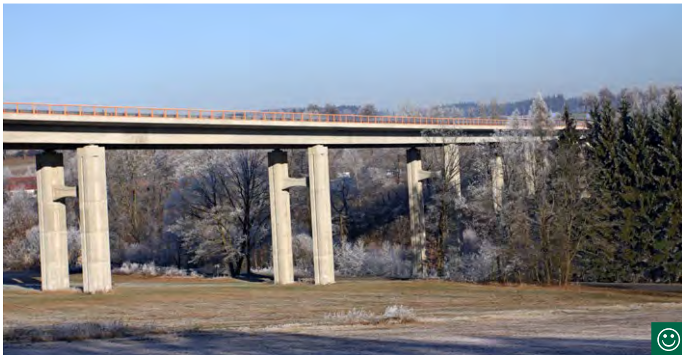
Obr. 10.43 Viadukty přes celá údolí umožňují průchod většině druhů živočichů, včetně velkých savců. V případě odpovídajících podmínek mohou propojovat celé ekosystémy. (© Václav Hlaváč)
