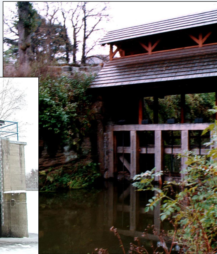
Obnovená stavidlová výpust na Novozámeckém rybníce
