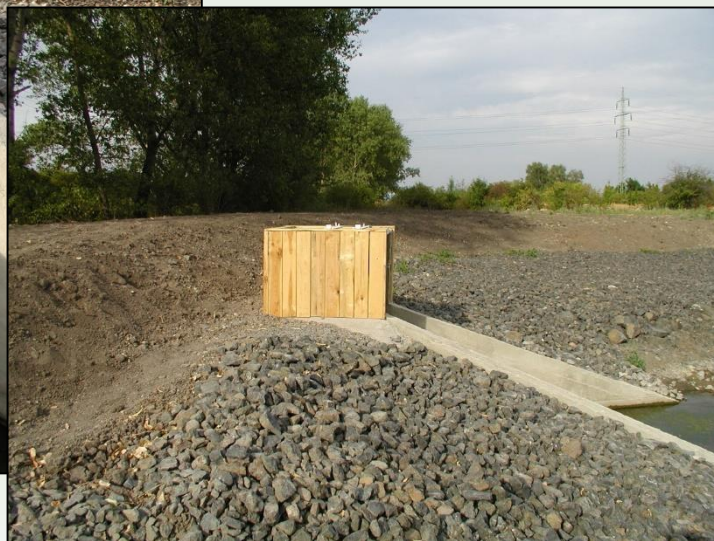
požerák na poldru v Sulejovicích (Modla) – dvířítá dlužová stěna, česle, obklad dřevem
