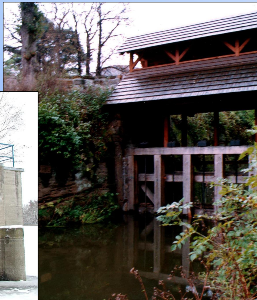
obnovená stavidlová výpust na Novozámeckém rybníce
