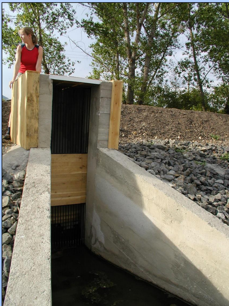
požerák na poldru v Sulejovicích (Modla) – dvojitá dlužová stěna, česle, obklad dřevem
