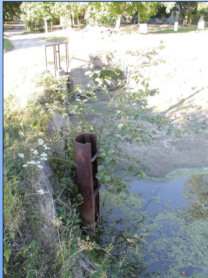
primitivní nefunkční požerák – MVN v Čeněticích, Botič
