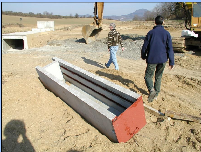
požerák jako součást sdrůženého objektu - ve výstavbě - MVN Břehoryje
