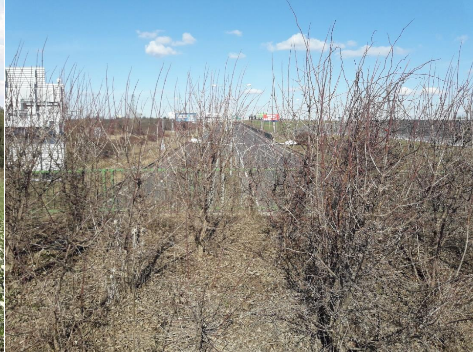
Pohled na dálnici D0 z ekoduktu z pohledu zvěře (chybí odclonění)
