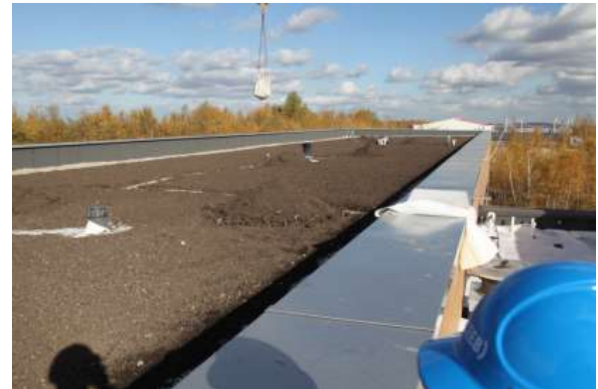
výstavba zel. střechy UCEEDB, ČVUT
