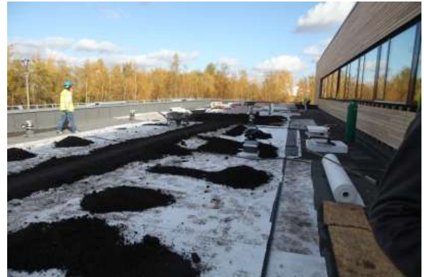
výstavba zel. střechy UCEEDB, ČVUT
