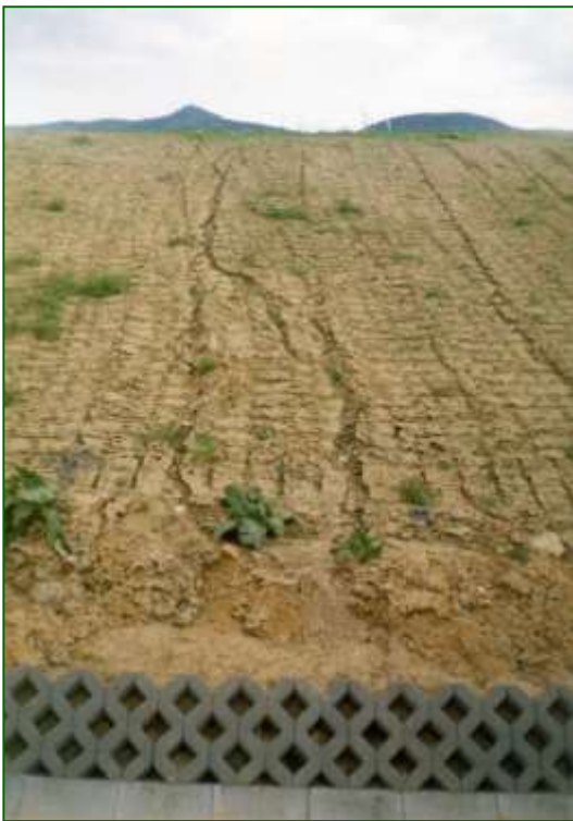
Eroze náspu komunikace
